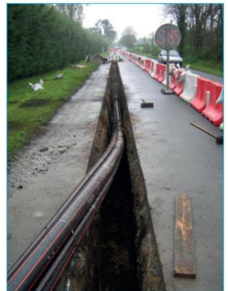
*Figure 7 : illustration de la pose en PEHD d'une liaison souterraine à un circuit*
