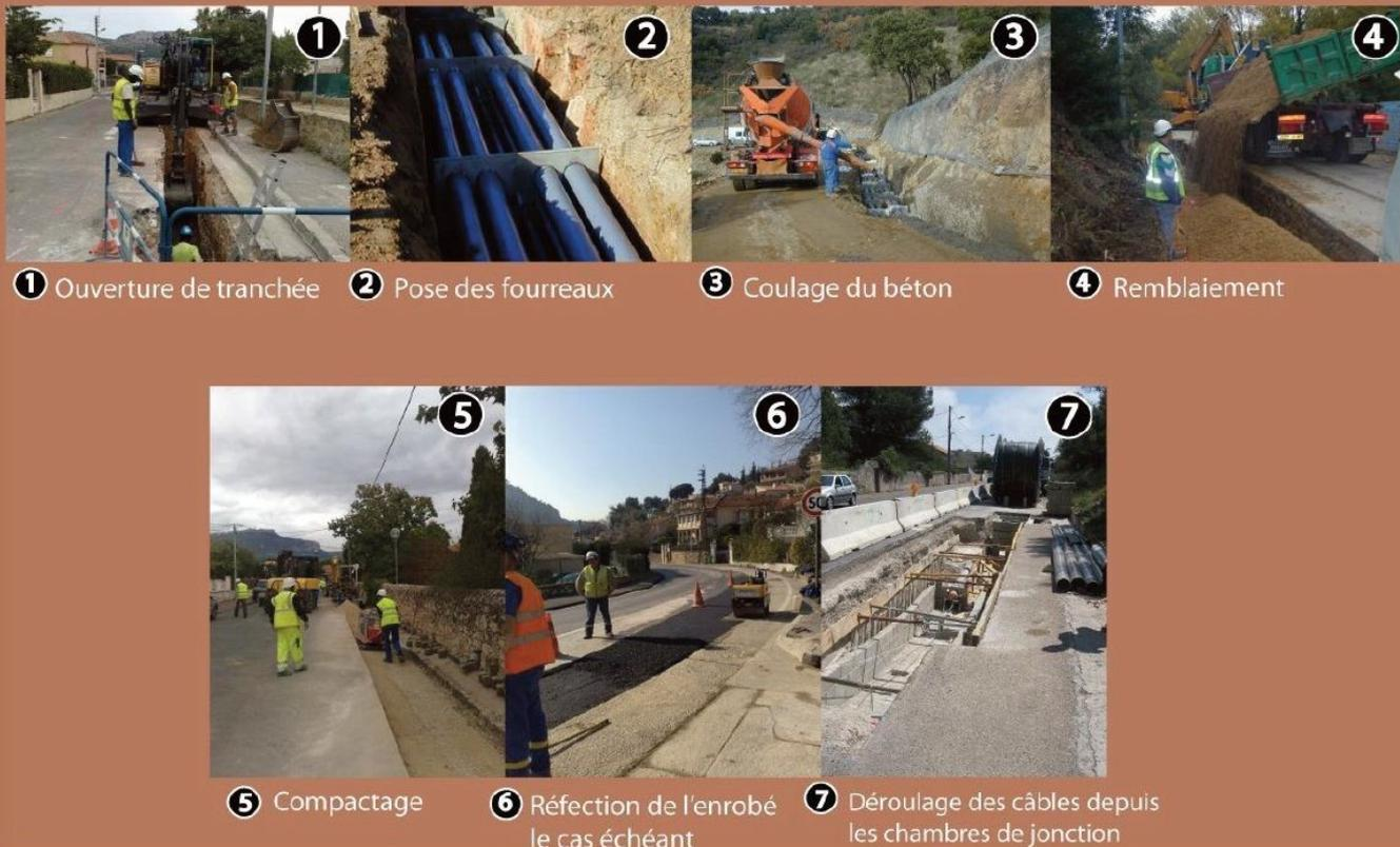
Figure 12 : Déroulement général de la phase travaux
