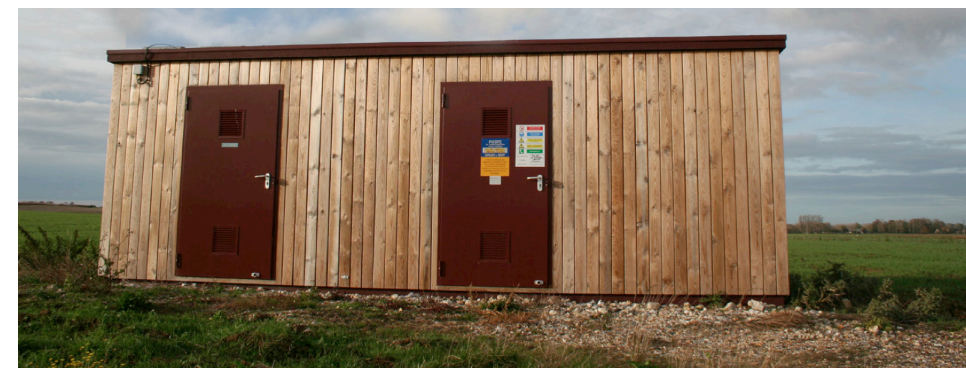
Exemple-type de poste de livraison
