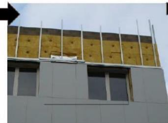
4- Gîte recouvert d'isolant avec bardage incomplet
