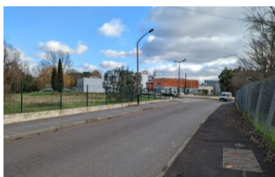
Figure n°79. Vue 6 : Entrée Nord – 2 ème accès au site
