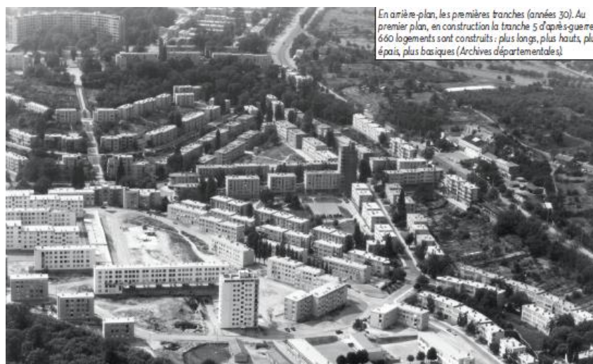
Les Nouvelles de Châtenay-Malabry de novembre 2020
