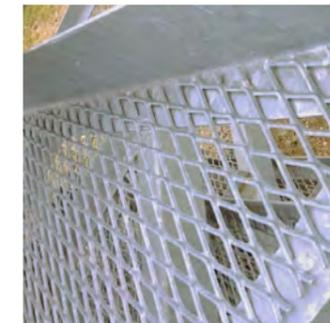
La résille métallique couvre les édicules techniques de VMC ainsi que les conduits apparents. La structure de la résille assurera un débord suffisant de part et d'autres des éléments techniques pour qu'ils ne soient pas visibles.
