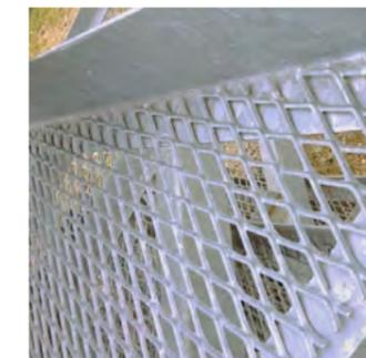
La résille métallique couvre les édicules techniques de VMC ainsi que les conduits apparents. La structure de la résille assurera un débord suffisant de part et d'autre des éléments techniques pour qu'ils ne soient pas visibles.
