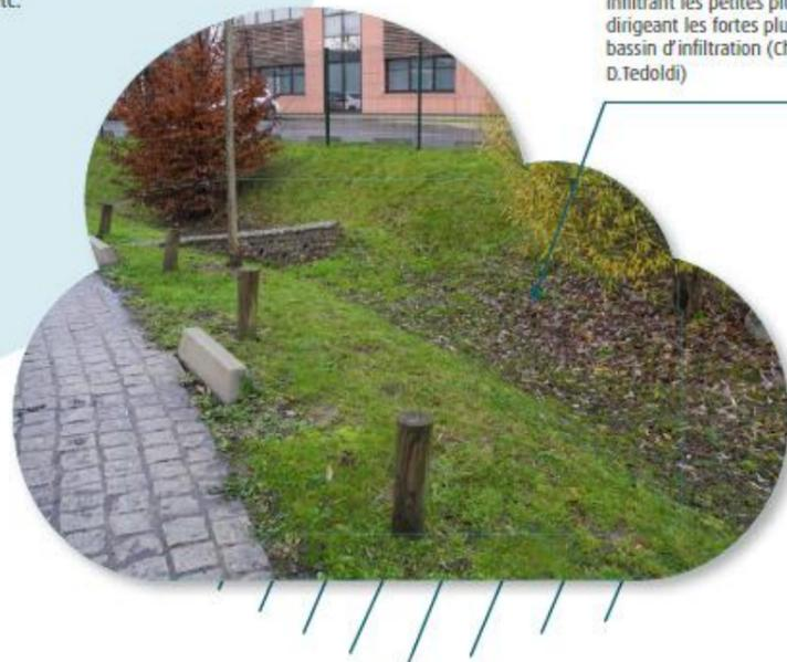
Figure 38 : Gestion des petites pluies (Source : Plaquette « Bien gérer les eaux de pluie, principes et pratiques en Ile-de-France », DRIEE, février 2019)
