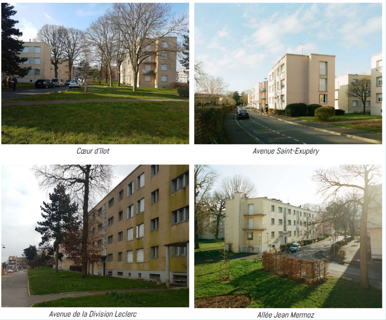
Figure 5 : Photographies de l'îlot test 1 - Mermoz (Source : Ville de Châtenay-Malabry)
