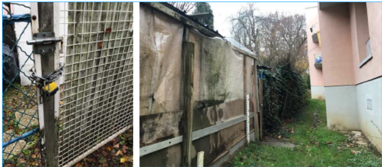
Figure 26 : Photographies des « en-communs paysagers » de la Cité Jardin (Source : Ville de Châtenay-Malabry)
