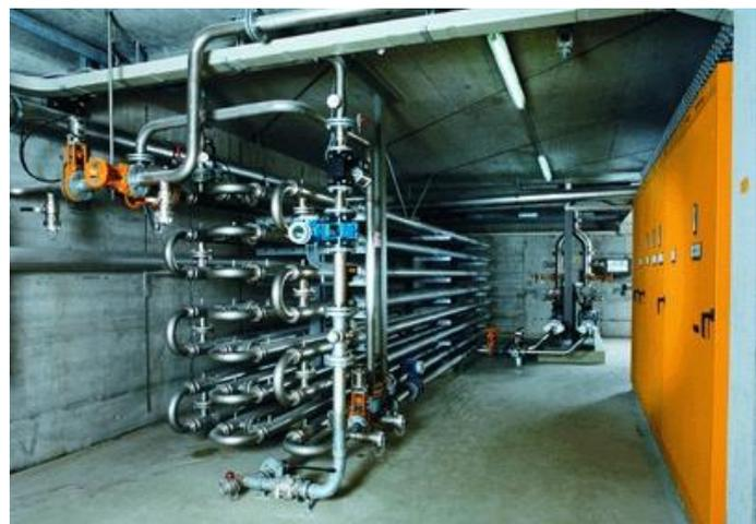
Figure 24 : Échangeur tubulaire en sortie de STEP (Lyonnaise des Eaux, ISTINOX, ANTEA)
