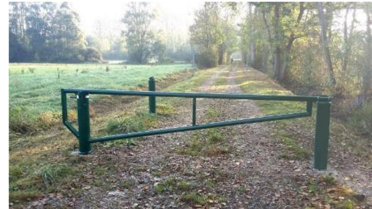
Figure 24 : exemple de barrière pivotante envisagée
