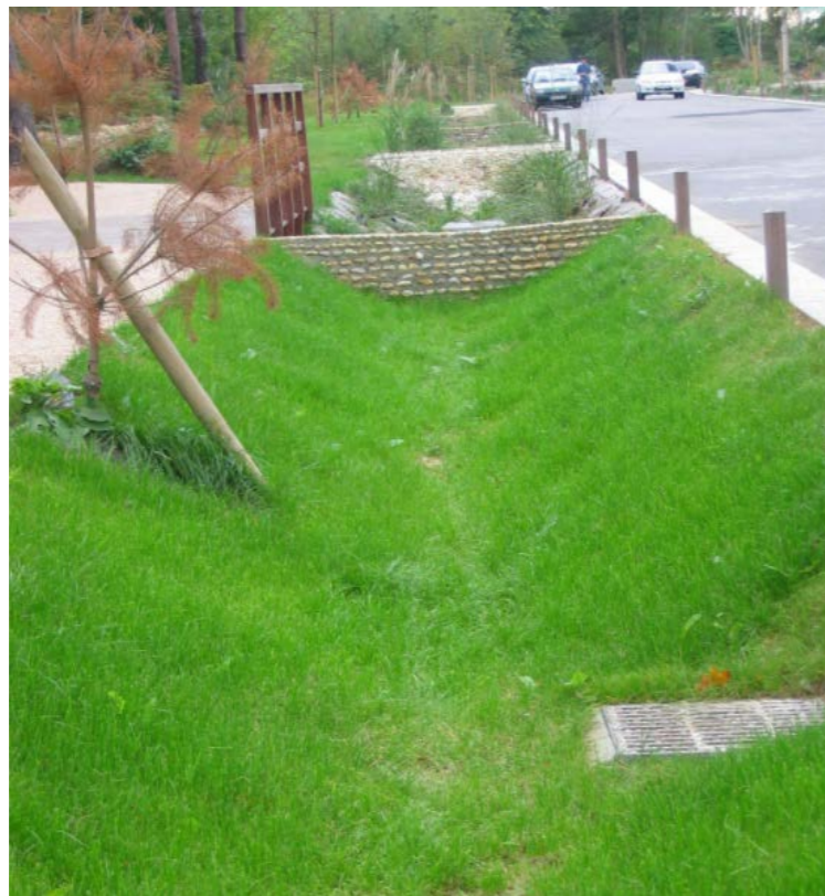
Figure 33 : Exemple de noue enherbée avec redans
