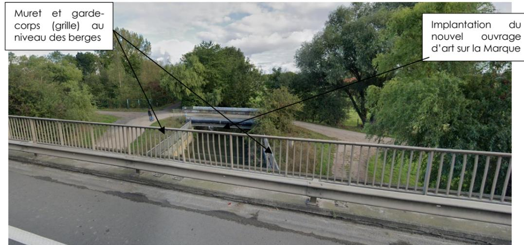
Figure 20 - Implantation du nouvel ouvrage d'art sur la Marque
