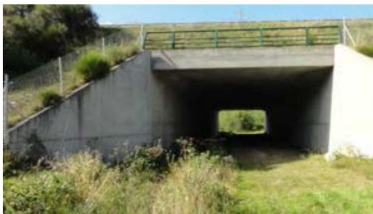
Illustration 7. Exemple de passage mixte Grande faune / hydraulique (Source : egis)
