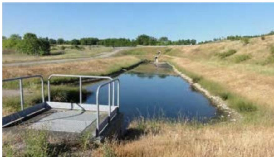
Illustration 8. Bassin de traitement et/ou régulation des eaux de plateforme de L'A680 élargie (Source : egis, 2021)
