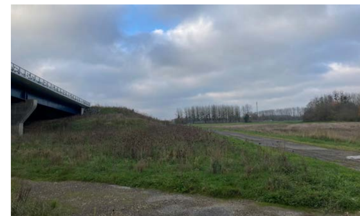
Figure 221 : Vue 9 : depuis le pied du viaduc au Nord – Source : Ingérop
