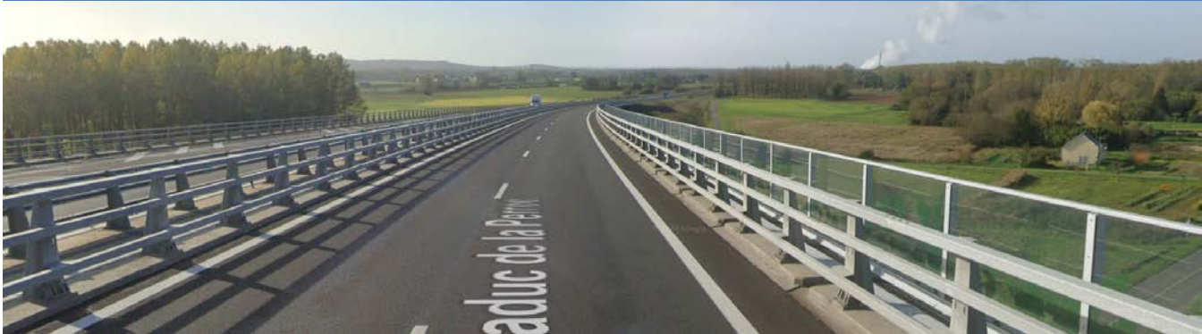
Figure 223 : Vue 11 : depuis le viaduc sur l’autoroute A85 en direction de Saumur – Source : Google
