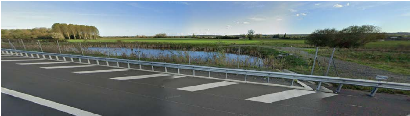
Figure 225 : Vue 13 – depuis l’autoroute A85, vue vers le Sud avec le bassin hydraulique en premier plan
