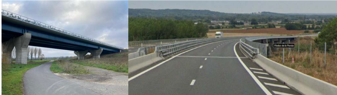
Figure 207 : Vues du viaduc de la Perrée à Coteaux-sur-Loire sur l'autoroute A85 – Source : Google Maps
