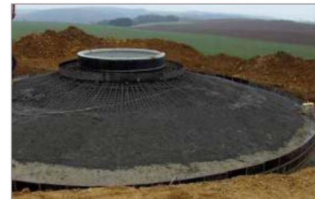
Photo 1 : Exemple de ferrailage en radier pour une éolienne
