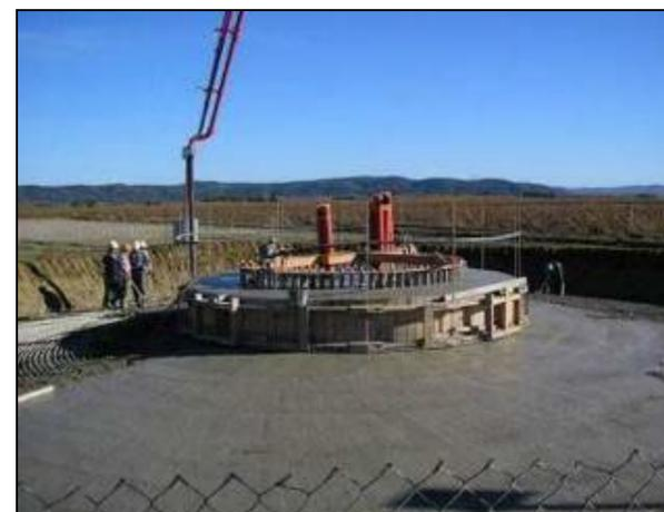
Photo 13 : Coulage du béton
