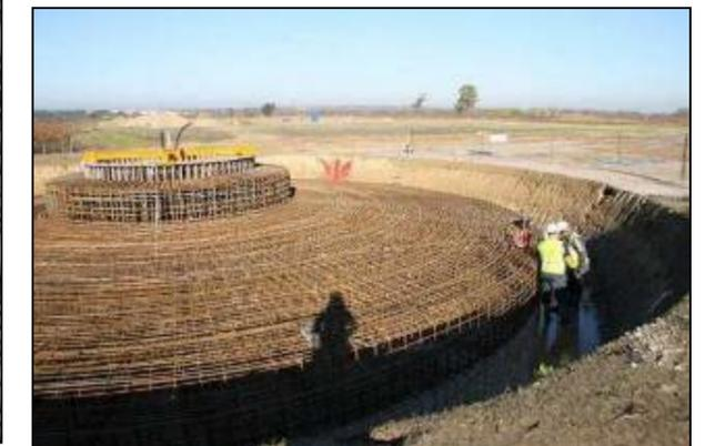
Photo 12 : Ferrailage de la fondation
