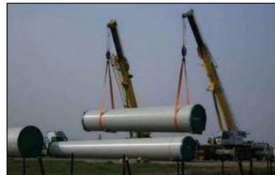
Photo 16 : Manipulation des tronçons d'éoliennes
