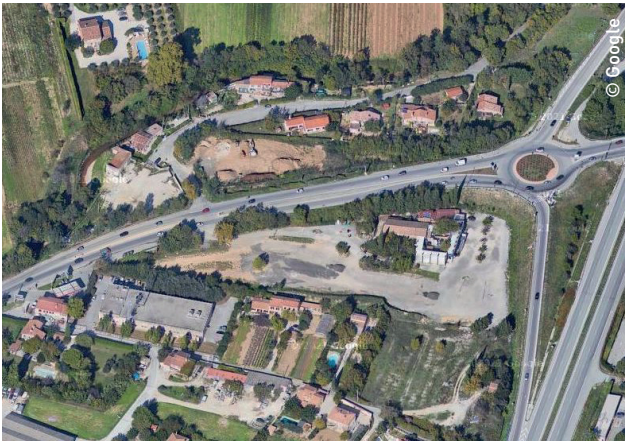
➤ Partie Nord du site avant travaux
