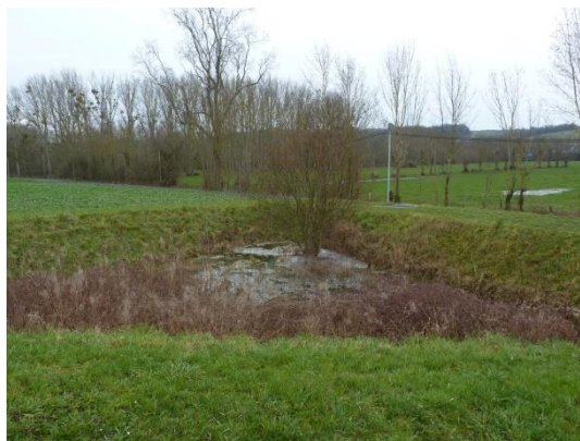
2. Bassin de rétention à proximité de la gendarmerie
