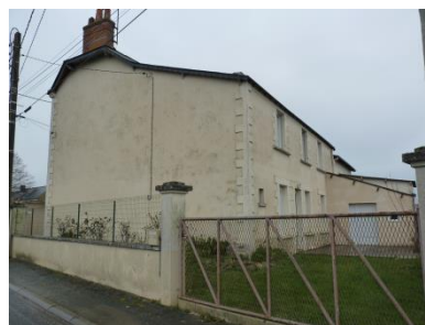
8. Bâtiment avec habitation
