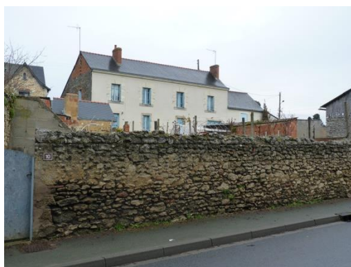
5. Mur en pierre rue Victor Hugo
