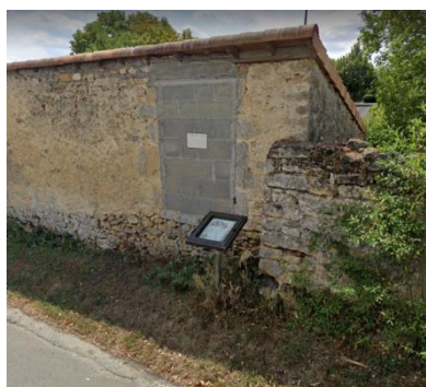
4. Panneau d'indication des anciens fours à chaux
