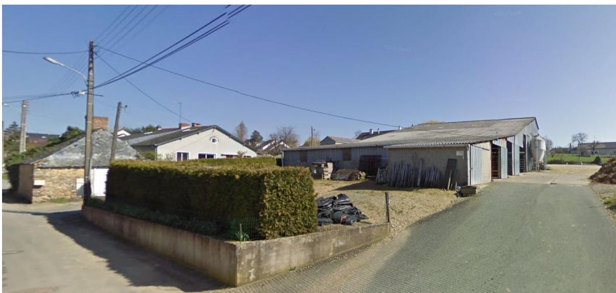
3. Ancienne stabulation, entrée depuis la rue de l'Abbaye
