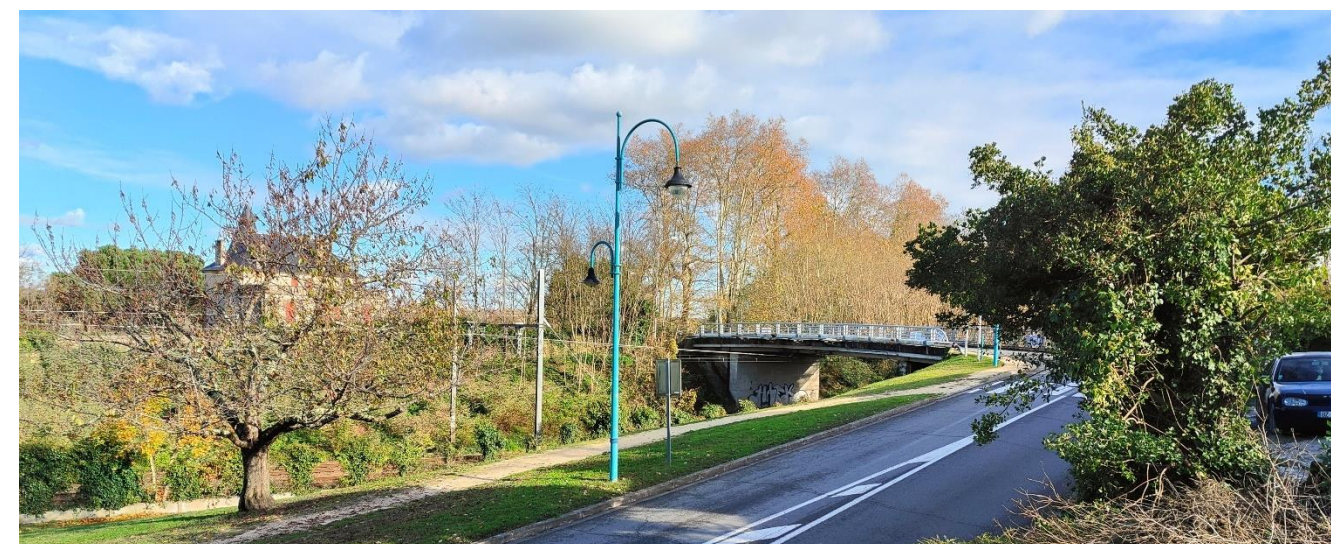
Photo de l'ouvrage existant prise depuis l'avenue de la gare
