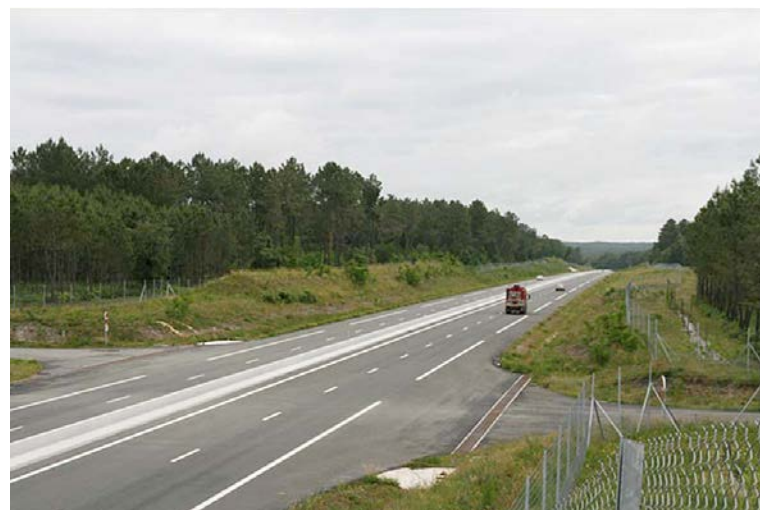
Autoroute A65 [Source Egis 2013]
