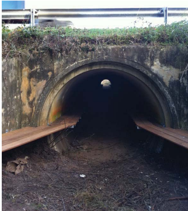
Figure 21: Photographie d'un aménagement de type encorbellement en bois
