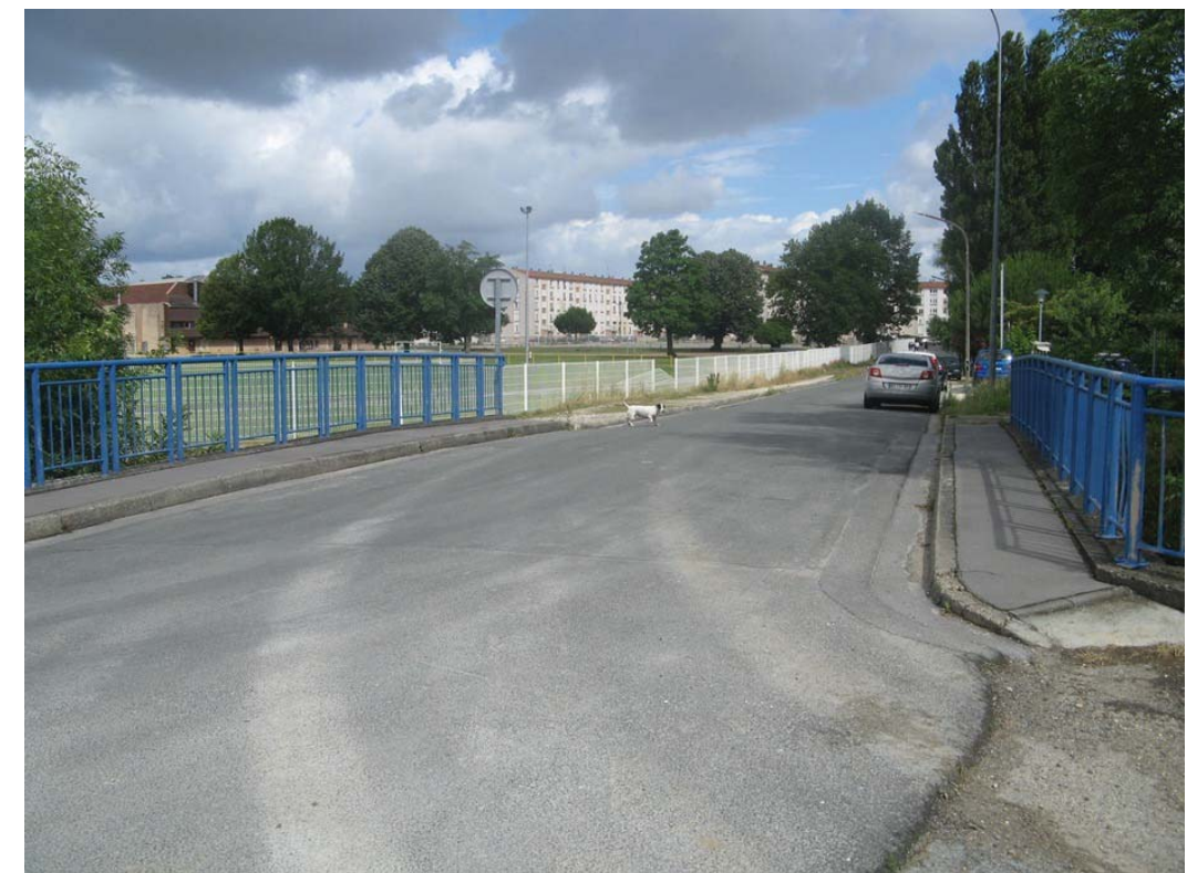
Figure 7: OH de franchissement en aval des lignes ferroviaires (OH3d)
