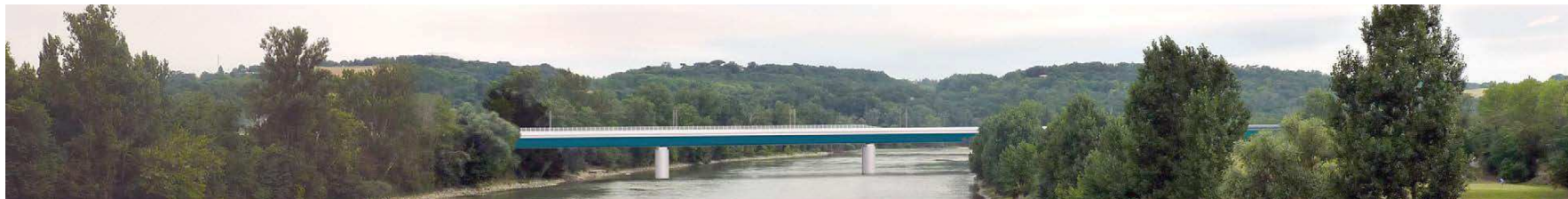
Franchissement de la Garonne [Source Egis]
