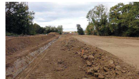
Fossé provisoire [Source Egis]
