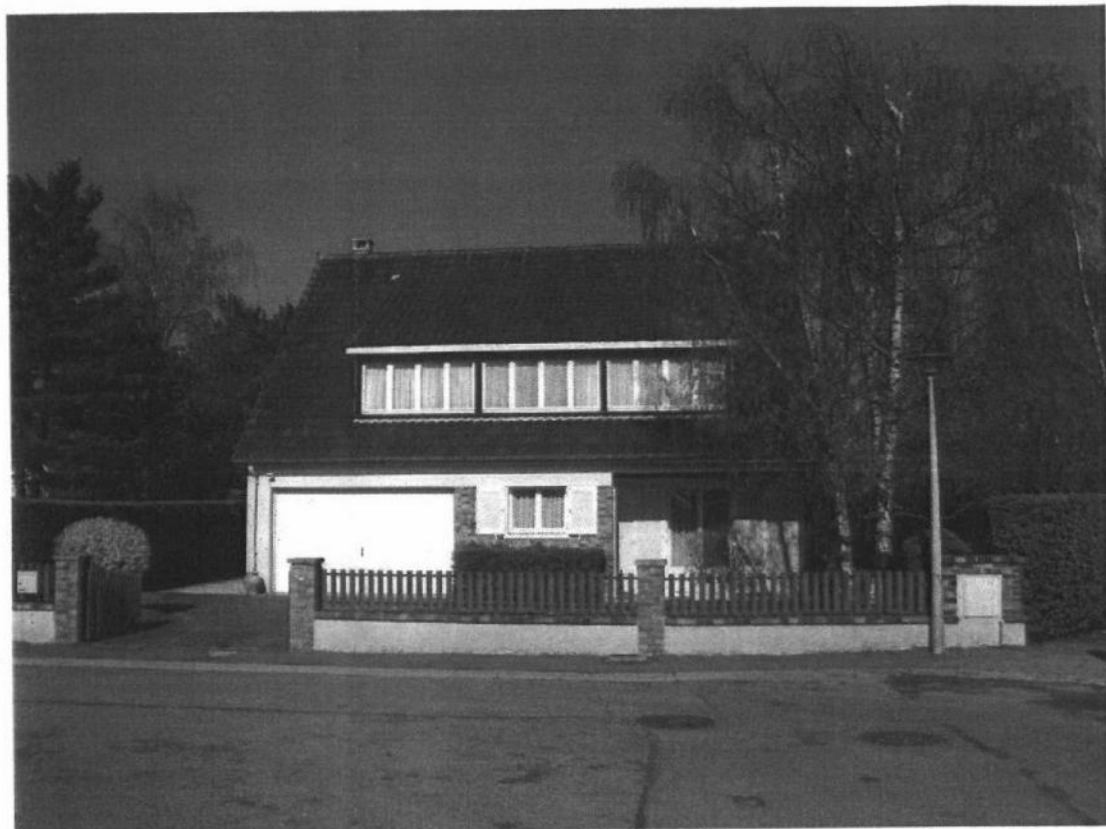
Maisons individuelles situées rue de Bourgogne dans le « Domaine des Marquis ». Elles constituent par rapport aux voies, emprises publiques et limites de propriétés dans une même configuration.
