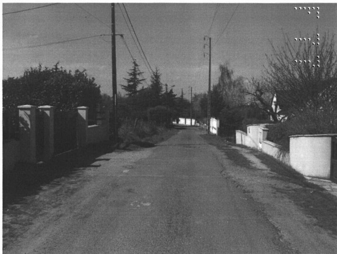
Chemin des Folies. L'espace public est très dégradé. La route est abîmée et ses abords ne font l'objet d'aucun traitement. Les réseaux électriques ne sont pas enterrés et l'hétérogénéité des clôtures est fortement perceptible.
