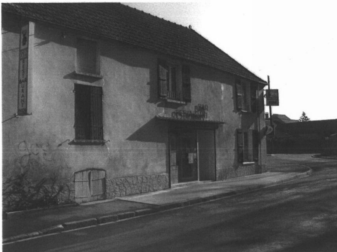
Bar-restaurant à l'angle de l'allée des Marquis et de la rue des Perriers.
