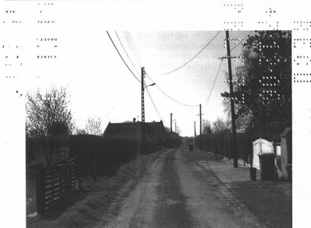
Vue depuis la voie communale n°5. Le hameau de Tremblesseaux se caractérise par la présence de maisons d'époques diverses et ne présentent pas un aspect capable de créer une véritable cohésion d'ensemble. Les réseaux téléphoniques et électriques sont aériens et ne contribuent pas à embellir le hameau.
