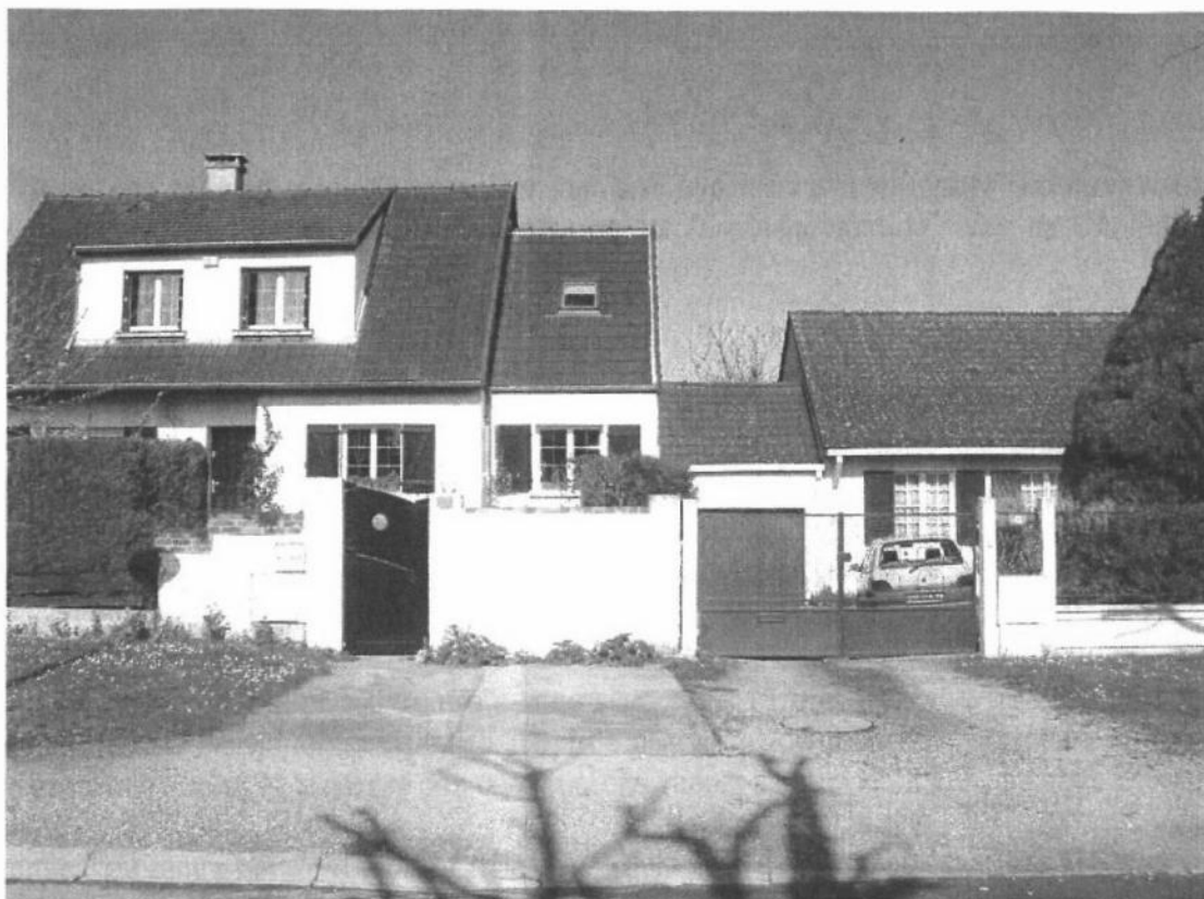
Allée des Marquis. Maisons individuelles mitoyennes sans cohérence. La hauteur des constructions est disparate et supprime l'alignement horizontal.
