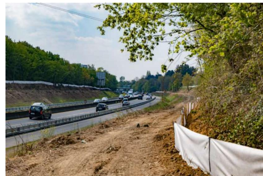
Figure 11: Exemple de bâche de protection
