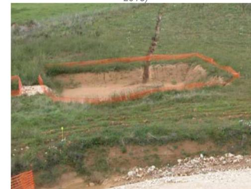
Figure 8: Exemple de fossé de collecte des eaux de chantier à faible pente (CEREMA 2015)
