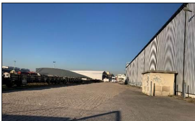
Photographie n°14 –bâtiment Eglise Million et poste Transformateur SILICE (Z88)
