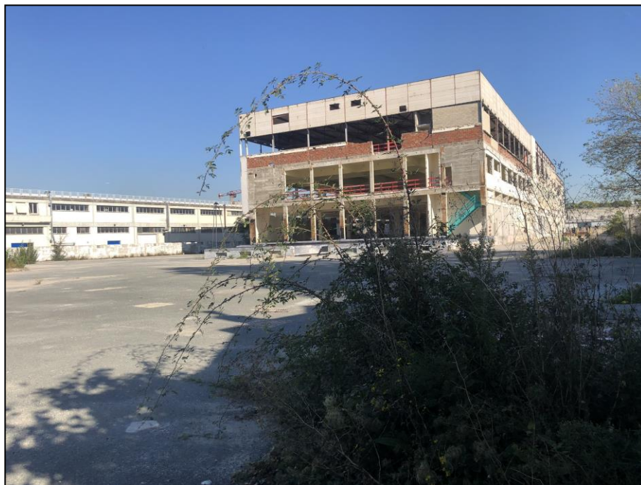
Photographie n°16 – Bâtiment en phase travaux
