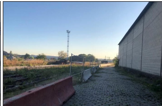
Photographie n°51 – vue sur les voies
