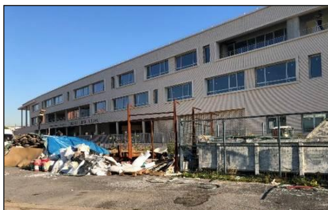
Photographie n°17 – Collège en travaux
