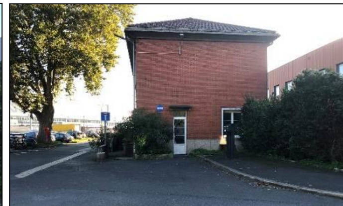
Photographie n°21 – Espaces extérieurs et bâtiment Red Art Factory
