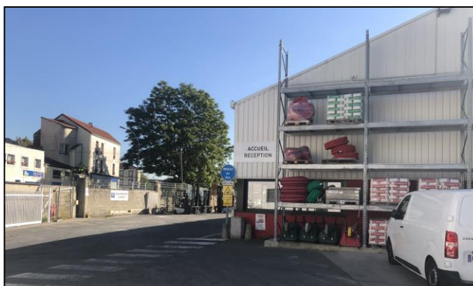
Photographie n°7 – entrée du site – vue sur l'entrepôt (façade ouest)
