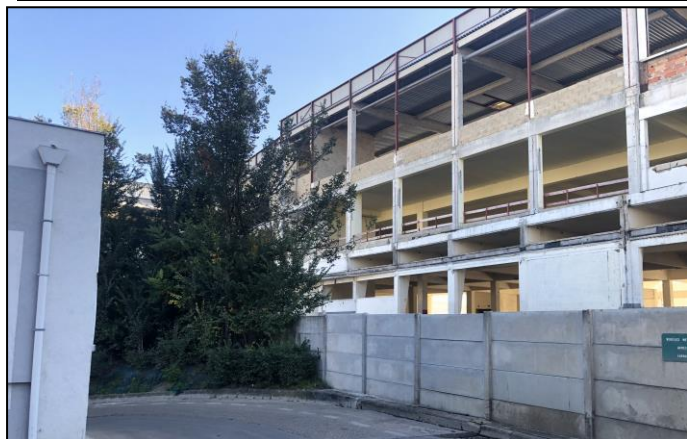
Photographie n°7 – bâtiment en phase travaux et vue sur la rampe d'accès du sous-sol
