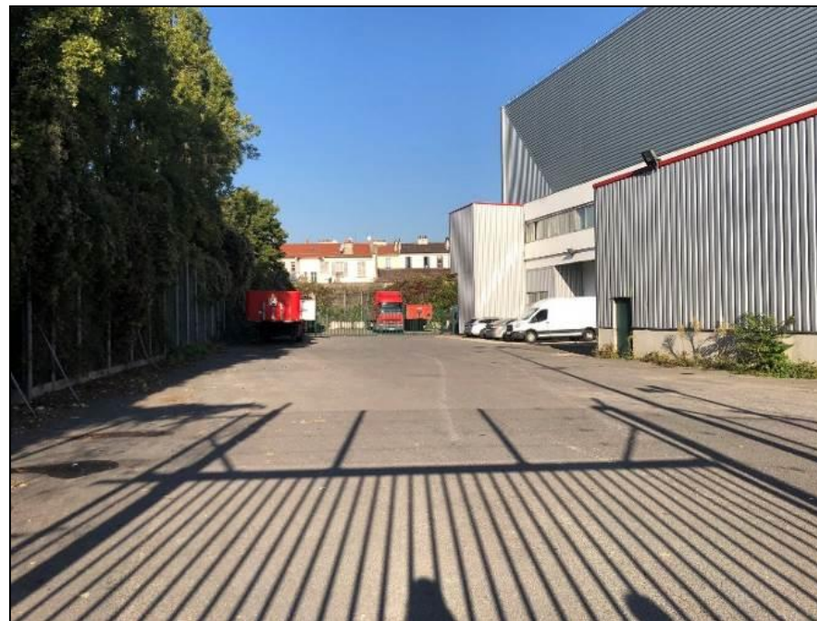
Photographie n°38 – Secteur ouest de l'entrepôt PANAME SERVICE
