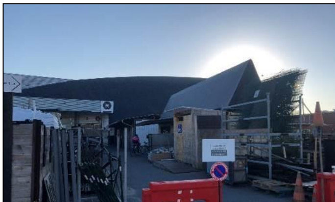
Photographie n°14 – Stockage au droit du bâtiment « Reserve des Arts »
