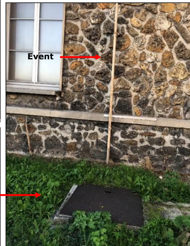
Photographie n°7a – Cuve enterrée au droit du poste de gardiennage (façade nord)
