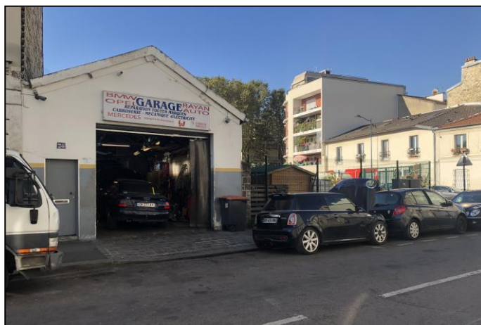
Photographie n°10 – Garage rue Cartier Bresson
