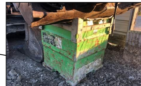
Cuve – géotextile présent
