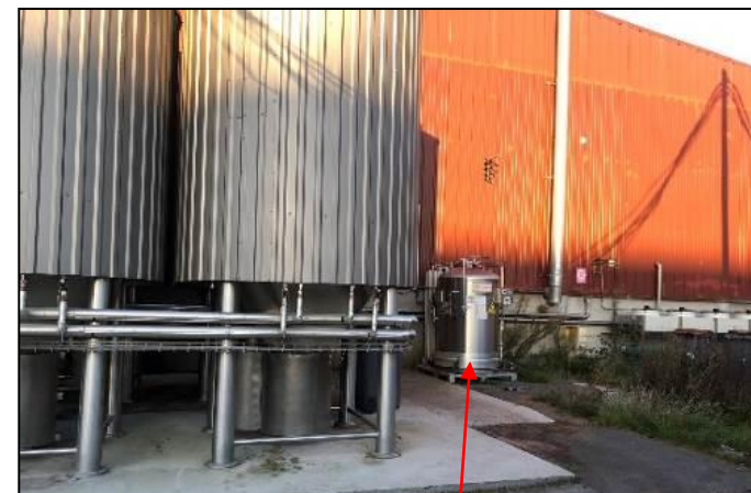
Photographie 20 – Tour de brassage et cuve air liquide
