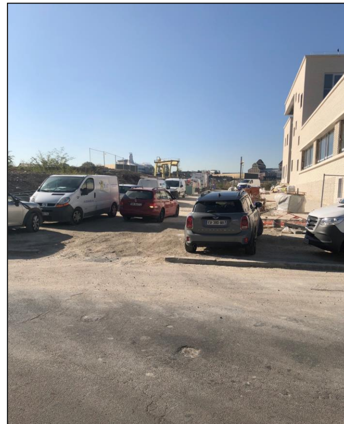
Photographie n°17 – Collège en construction
