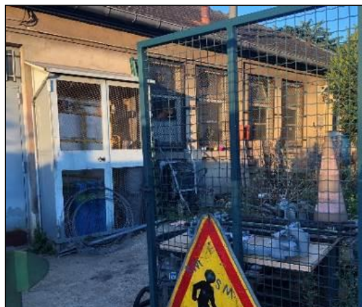
Photographie n°4 – bâtiment SNCF en activité (LOT 1)
