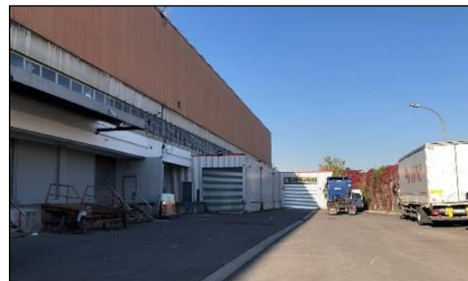
Photographie n°35 – Arrière des entrepôts PANAME SERVICE (façade nord)
