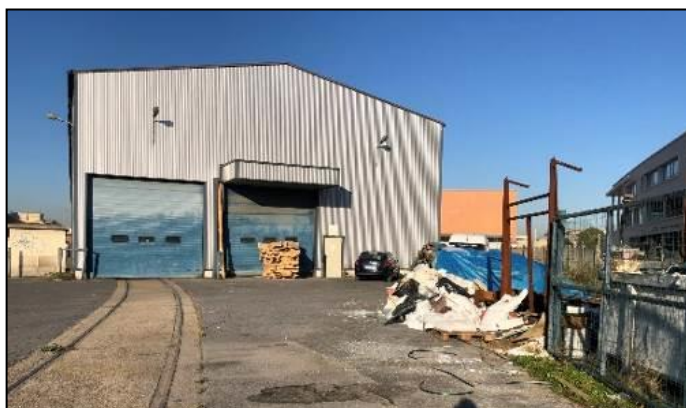
Photographie n°16 – arrière bâtiment Eglise Million et stockage divers
