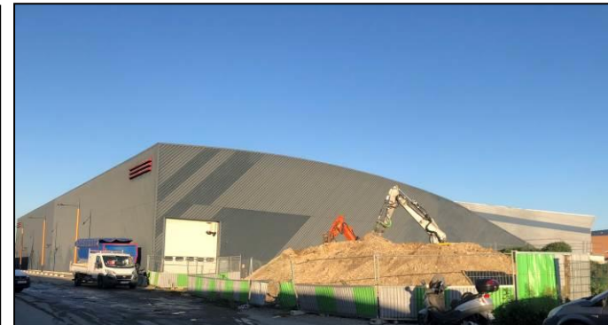
Photographie n°45 – Chantier/Stockage de terre –au droit des entrepôts de la réserve des arts et Lemon Tri (façade ouest)
