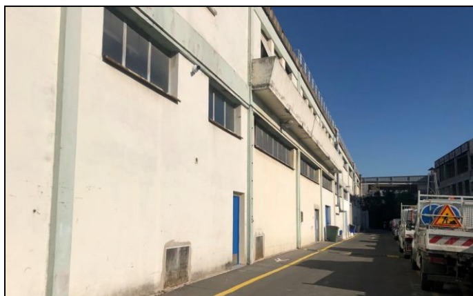
Photographie n°4 – bâtiment du centre technique
