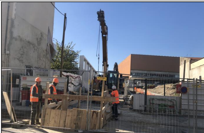
Photographie n°2 – vue sur le collège en construction
