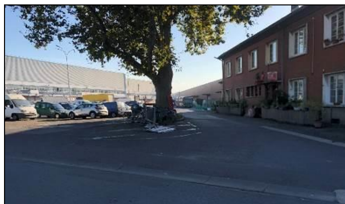
Photographie n°22 – Espaces extérieurs et bâtiment Red Art Factory
