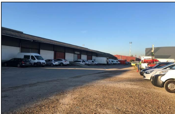
Photographie n°49 – Espaces extérieurs et entrepôts
