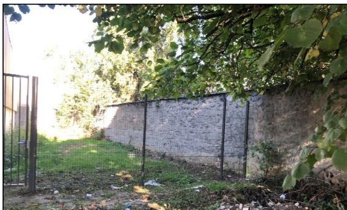
Photographie n°9 – Vue sur l'arrière du bâtiment (au nord)
