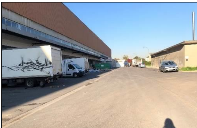
Photographie n°31 – Arrière des entrepôts – façade nord
