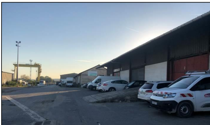
Photographie n°46 – Espaces extérieurs et entrepôt (ALLO PRIMO, RAKOMAT, TRANSPORTS & CO)
