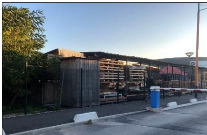
Stockage palette (bâtiment réserve des Arts)
