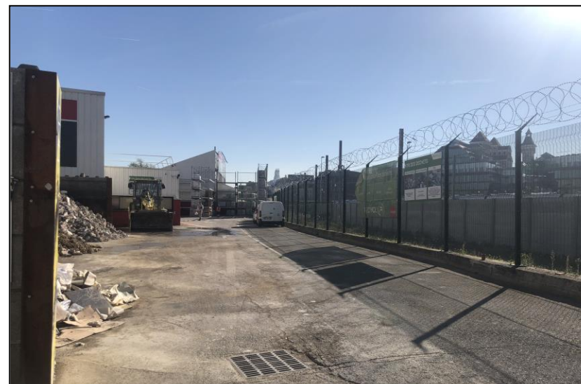
Photographie n°12 – stockage et vue sur les voies ferrées (à gauche)
