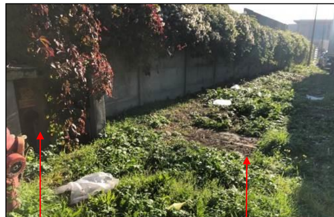
Photographie n°32 – Localisation de la cuve
