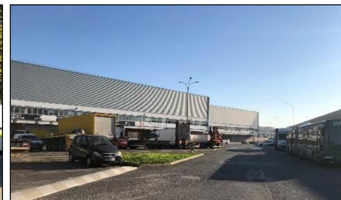
Photographie n°24 – Espaces extérieurs entrepôt PANAME SERVICE (façade sud)
