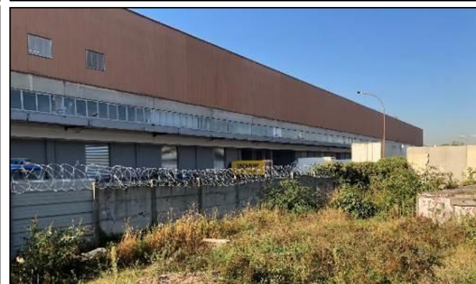
Photographie n°30 – Vue sur l'arrière des entrepôts PANAME SERVICE
