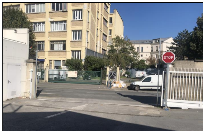
Photographie n°1 – Entrée du site – rue du Chemin de Fer
