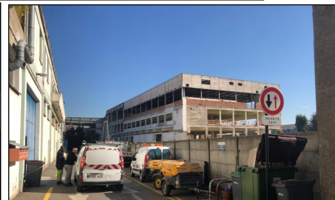
Photographie n°3 – bâtiment du centre technique et bâtiment en phase travaux
