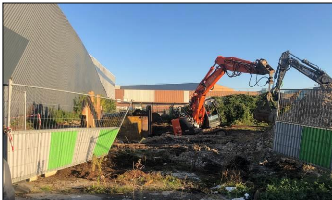
Photographie n°44 – Chantier au droit des entrepôts de la réserve des arts et Lemon Tri (façade ouest)
