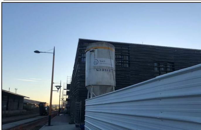
Photographie n°29 – Espaces extérieurs et bâtiment au droit du lot 18 (à droite)
