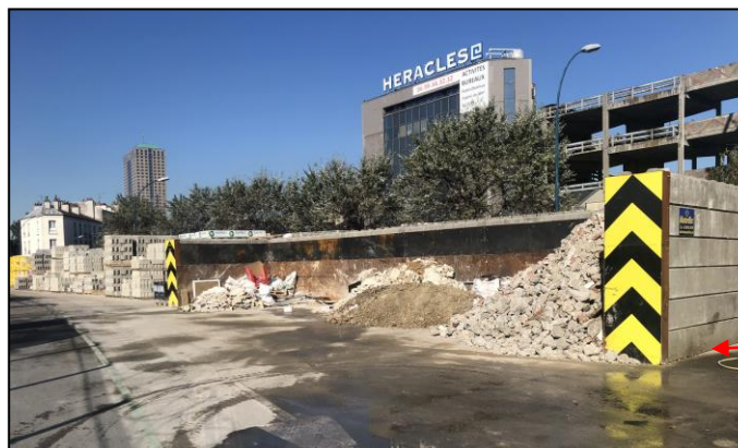
Photographie n°9 – stockage de déblais et de parpaing
