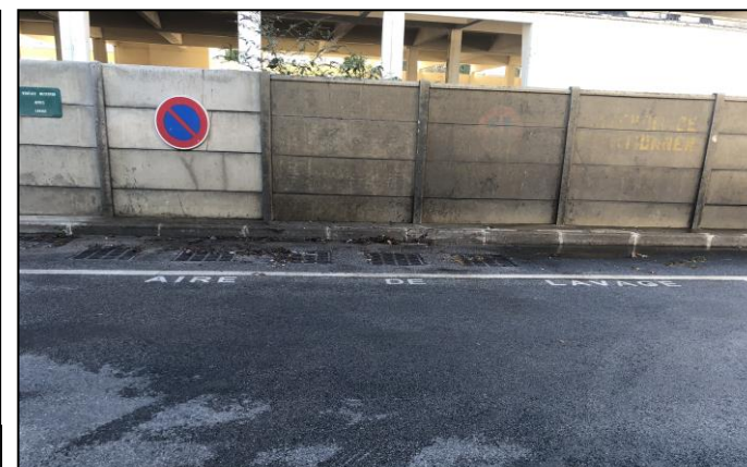
Photographie n°6 – Aire de lavage du Centre technique
