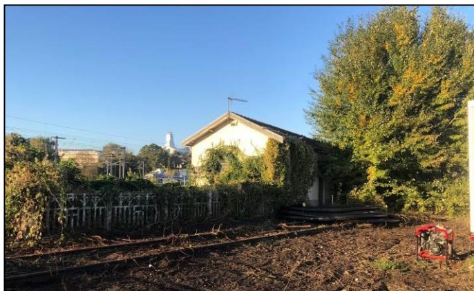
Photographie n°40 – Bâtiments le long de voies de chemin de fer
