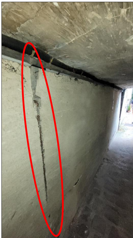
Cliché n° 12 : descente partiellement incorporée dans la maçonnerie du séparatif et visible dans le passage sous le pavillon du 22 rue Nationale
