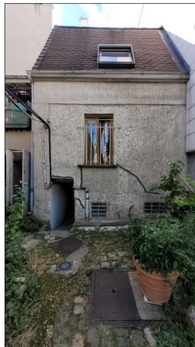
Cliché n° 11 : façade sur pavillon côté cour
