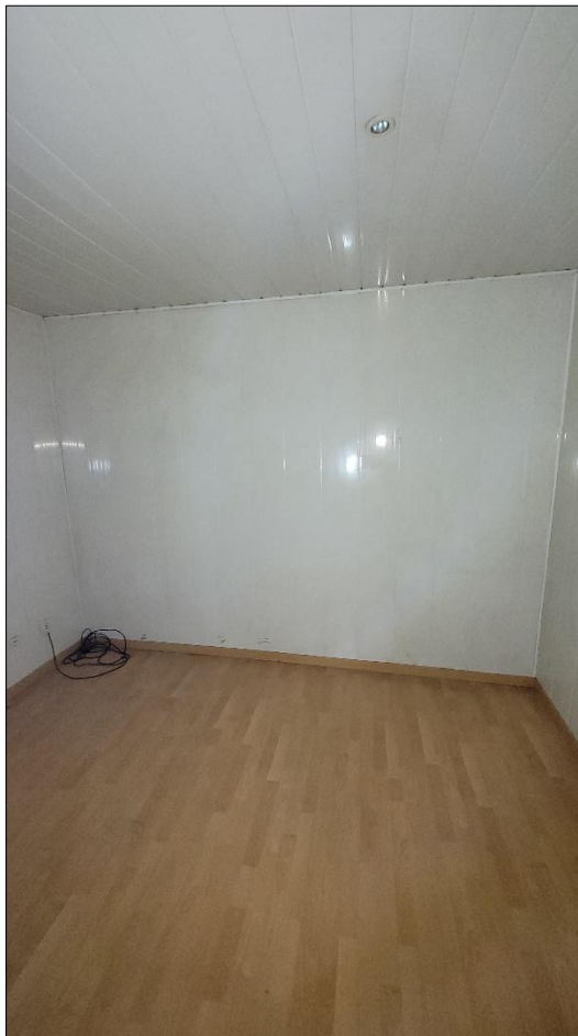
Cliché n° 26 : vue intérieure du bâtiment 2 en rez-de-chaussée, habillages en lames plastiques masquant entièrement les structures
