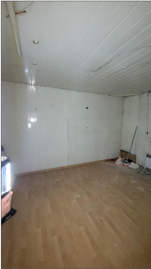
Cliché n° 20 : vue intérieure du bâtiment 1 en rez-de-chaussée, présence d'habillages en lames plastiques masquant entièrement les structures
