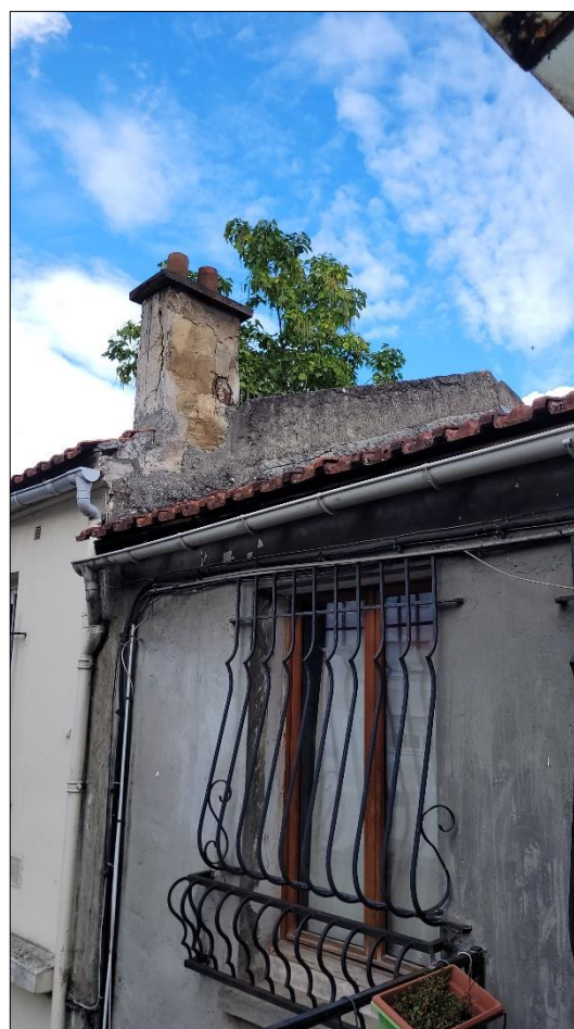
Cliché n° 25 : potentielle surélévation du séparatif entre bâtiments 2 et 4, avec souche de cheminée incorporée dans la maçonnerie
