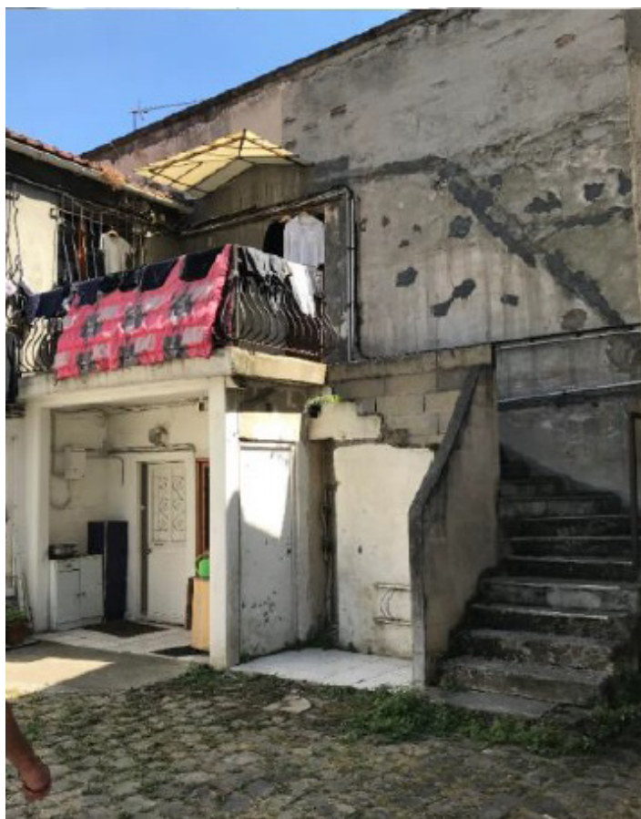
Vue actuelle du revers du 22, passage National depuis la cour (© Soreqqa).
