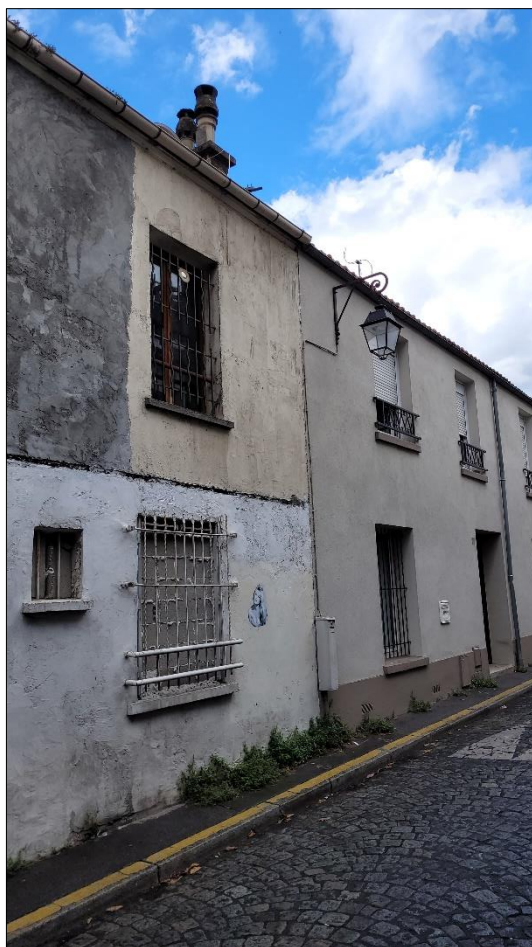
Cliché n° 18 : façades sur passage Nationale dans la zone C
