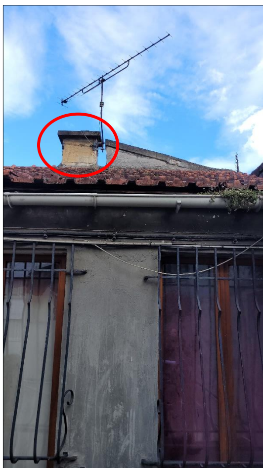
Cliché n° 24 : souche de cheminée en toiture au niveau du séparatif du bâtiment 2
