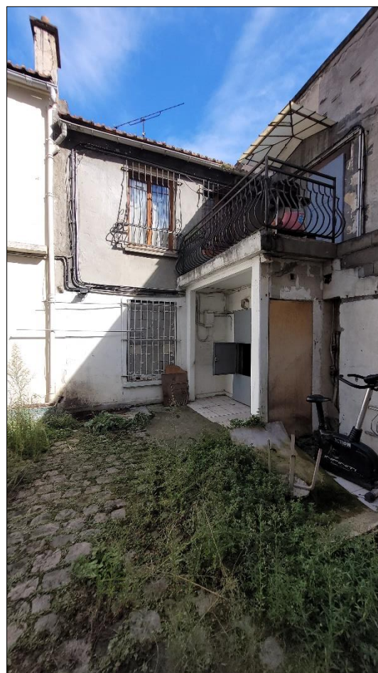
Cliché n° 19 : façades sur cour des bâtiment 1 et 2
