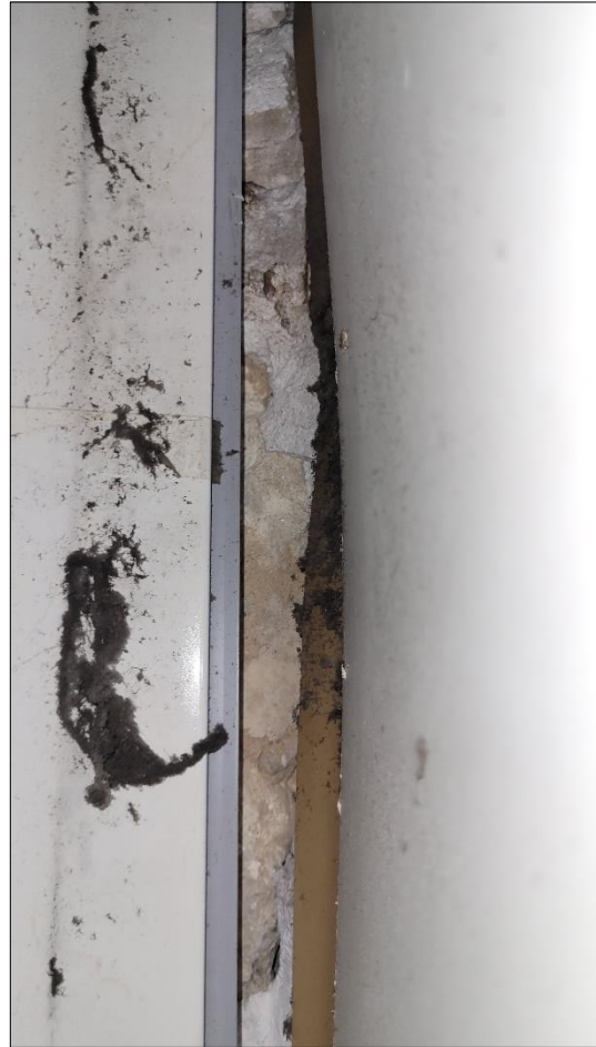
Cliché n° 21 : maçonnerie de moellons du mur séparatif observé dans l'angle avec la façade derrière l'habillage en lames plastiques
