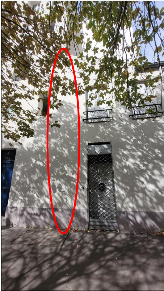
Cliché n° 7 : limite entre immeuble conservé et bâtiment démoli en zone A côté passage Nationale
