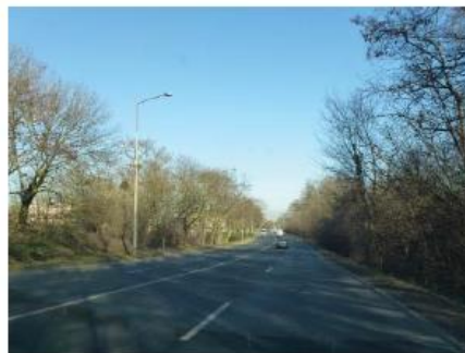
Le boulevard du Ru de Nesle dans sa section nord
