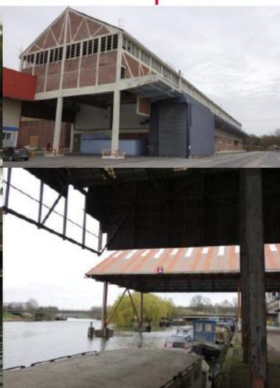
Héritage architectural fort → caractère atypique du site
