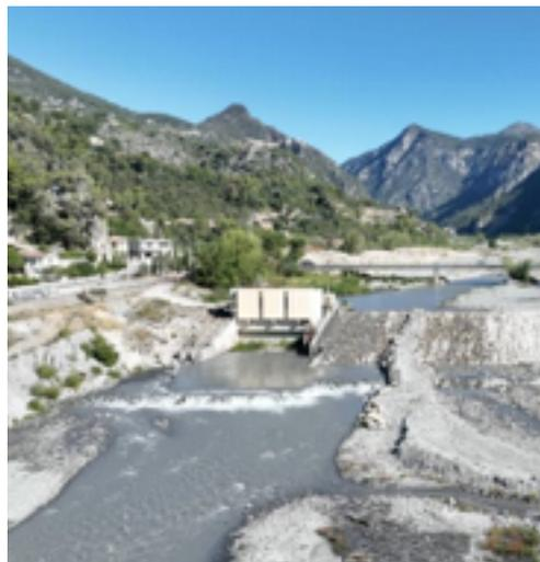
L'abaissement à réaliser des seuils 6, 5 et 4 sera accompagné du démantèlement des trois micro-centrales qui y sont installées. Le démantèlement consiste en un arrêt du fonctionnement, la démolition du bâtiment et des plateformes béton et la remise en état du lit du Var dans son état naturel.
