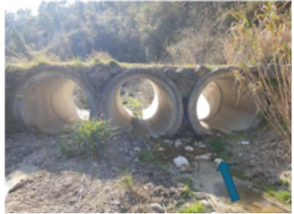
Photographie de l'ouvrage de franchissement (3 x 2200 mm) actuel et déplacement du problème de l'aval vers l'amont
