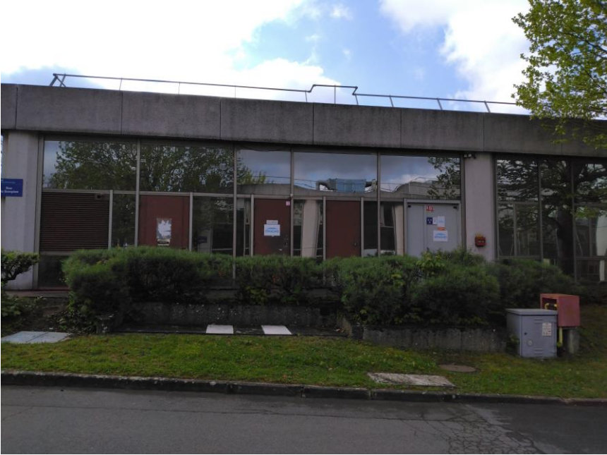
Malé : locaux techniques
