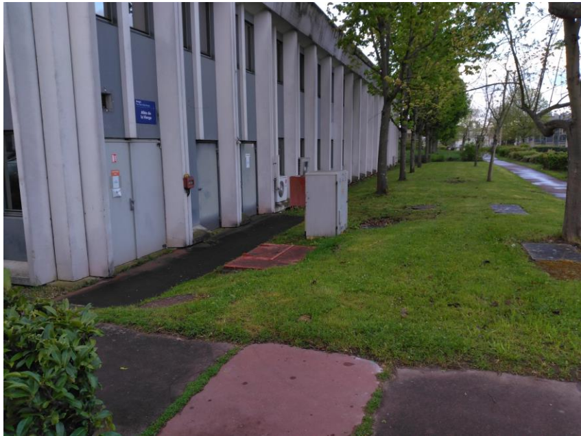
Nord du bâtiment Adélaïde
