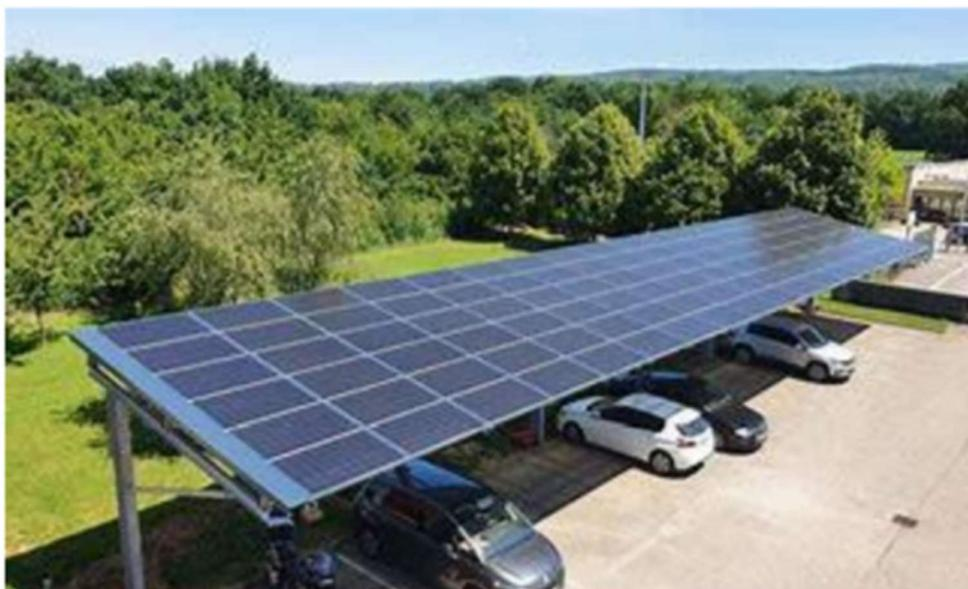
*Figure 17 : Exemple d'ombrières photovoltaïques sur places de stationnement (source : Imogis)*
