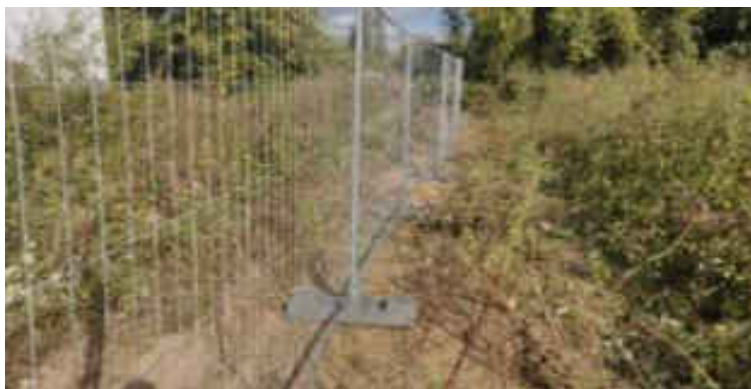
Figure 108 : Exemple de clôture fixe en guide de balisage à mettre en place sur le chantier
