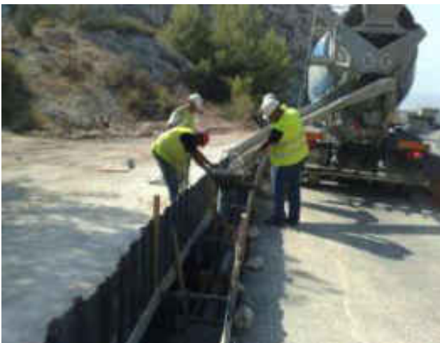
Coulage du béton
