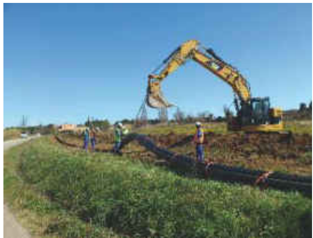
Pose des fourreaux PEHD en pleine terre
