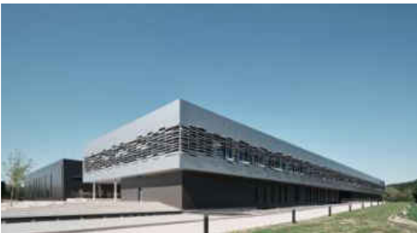
Exemples de façades en panneaux métalliques (Manufacture Chanel, ENIA architectes, 2017)
