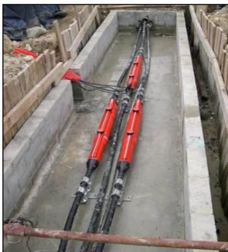
Des puits de terre ou de permutation sont parfois implantés à proximité de certaines chambres de jonction. Ils constituent des chambres visitables et en partie visibles en surface (tampons/regards affleurants). Le cas échéant, ces puits abritent les dispositifs de permutation des écrans de câble entre phases, ou de mise à la terre des écrans.
