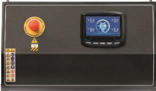
Le M80-D peut être utilisé comme bornier de base pour le raccordement d'une armoire de commande et comme panneau de contrôle muni d'un écran LCD très intuitif donnant un aperçu des paramètres de base de votre groupe électrogène :
