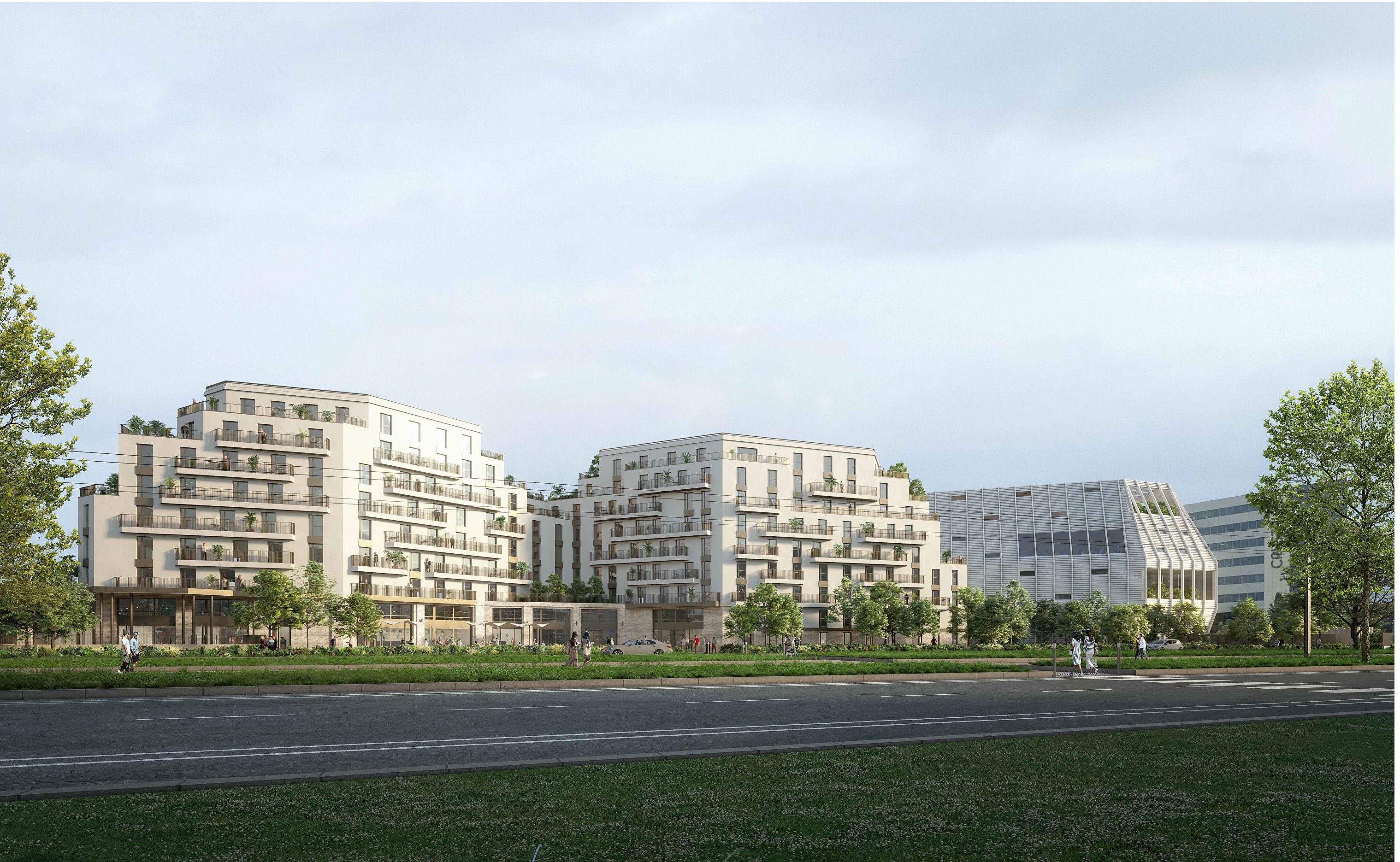
VUE DES BÂTIMENTS DEPUIS L'OUEST
