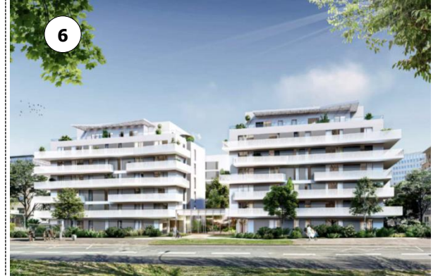
Projet rue Dame Grange Rose (en cours)
