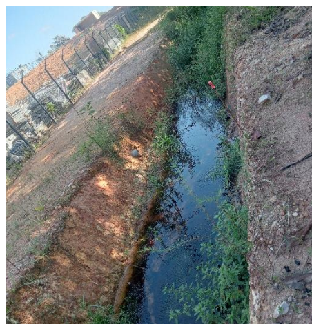
Section de ruisseau déviée par l'entreprise, prenant la forme d'un fossé rectiligne, aux berges et fond du lit droits et nus – On observe de plus la fermeture d'une partie du fossé avec la construction d'une structure bétonnée
