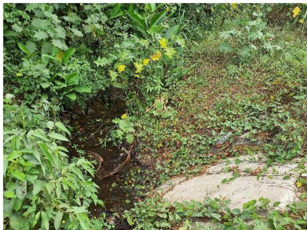
*Déviation du ruisseau au passage de la nouvelle piste d'accès, avec l'installation d'une buse qui apparaît sous-dimensionnée par rapport au gabarit du ruisseau*
