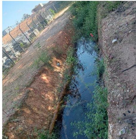
*Section de ruisseau déviée par l'entreprise, prenant la forme d'un fossé rectiligne, aux berges et fond du lit droits et nus – On observe de plus la fermeture d'une partie du fossé avec la construction d'une structure bétonnée*
