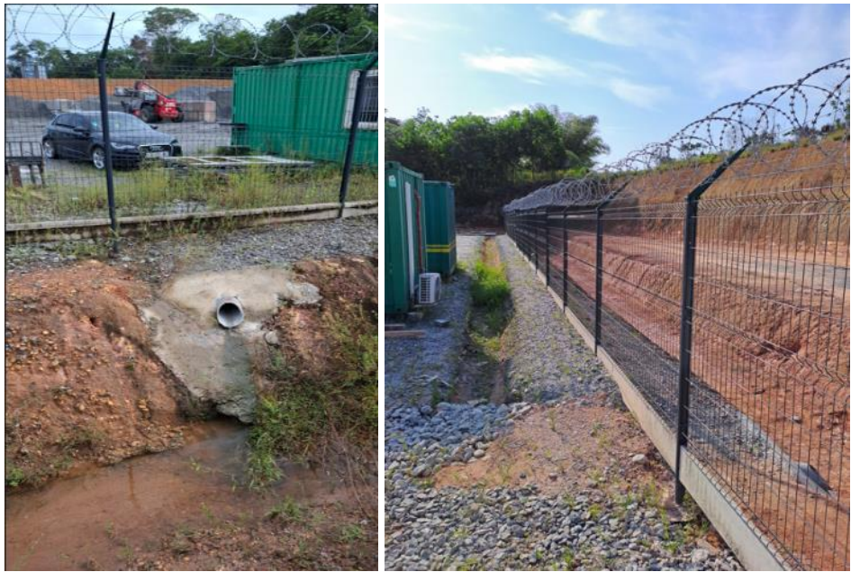
Figure 48 : Ouvrages n°1 et 2
