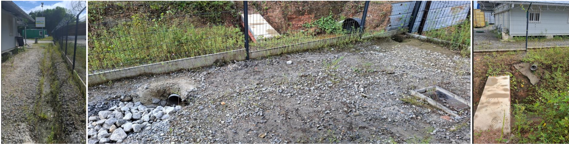
Figure 49 : Ouvrages n°3 et 4
