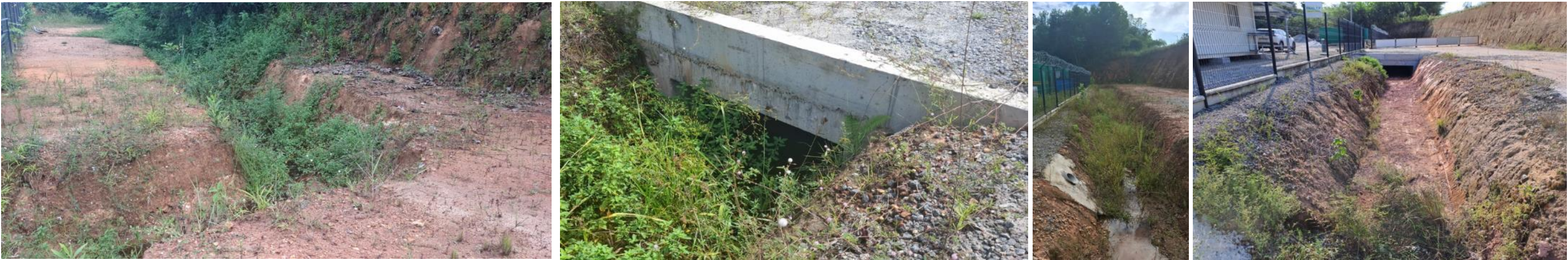
Figure 50 : Ouvrages n°5, 6 et 7
