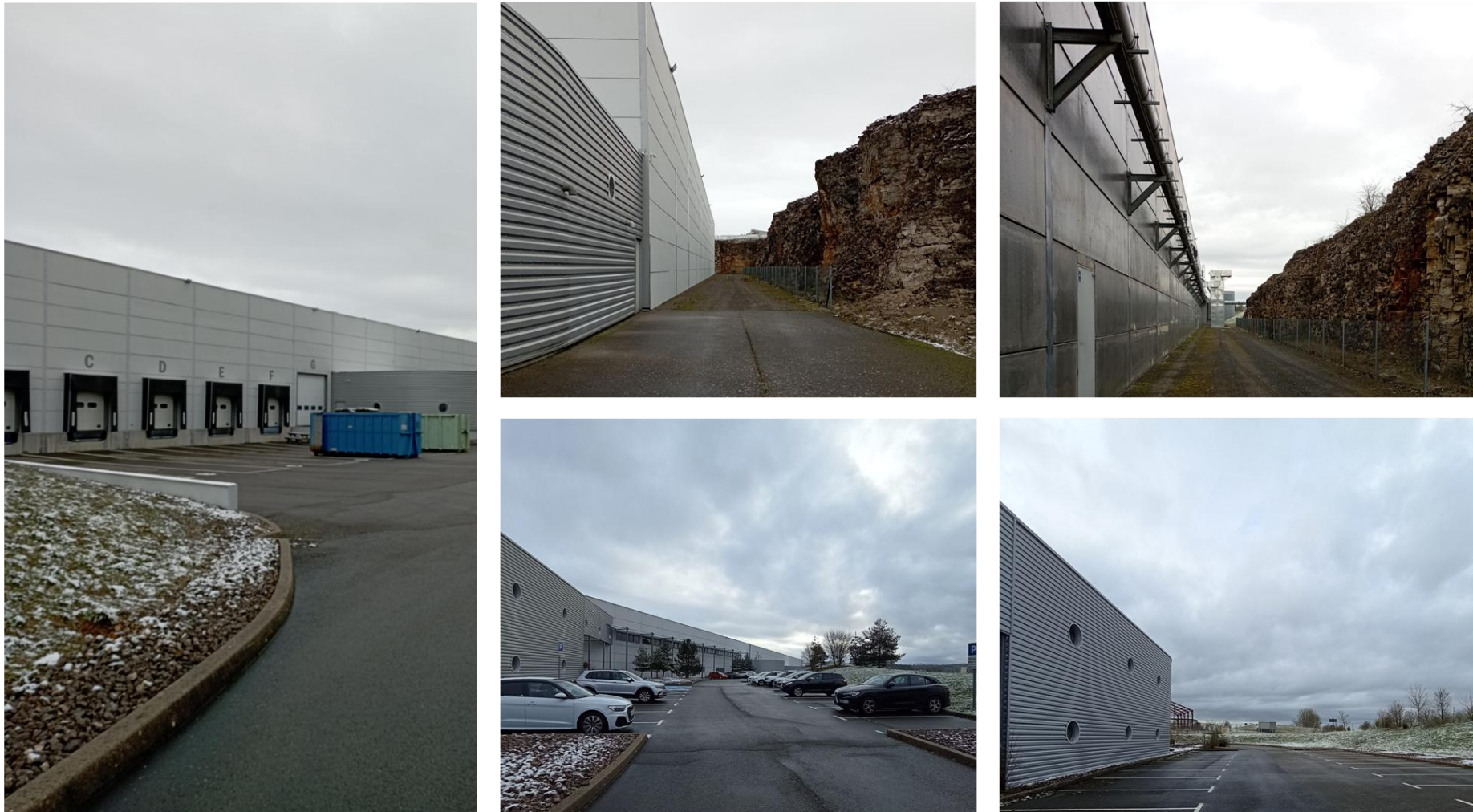
Figure 4 : Vues du site
