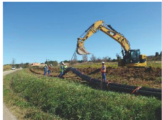
Pose des fourreaux PEHD en pleine terre.
