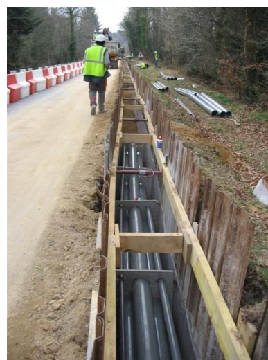
Coupe type d'une liaison souterraine en technique 225 000 volts (pose en trèfle)
