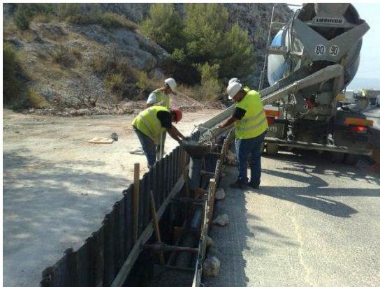
Coulage du béton.
