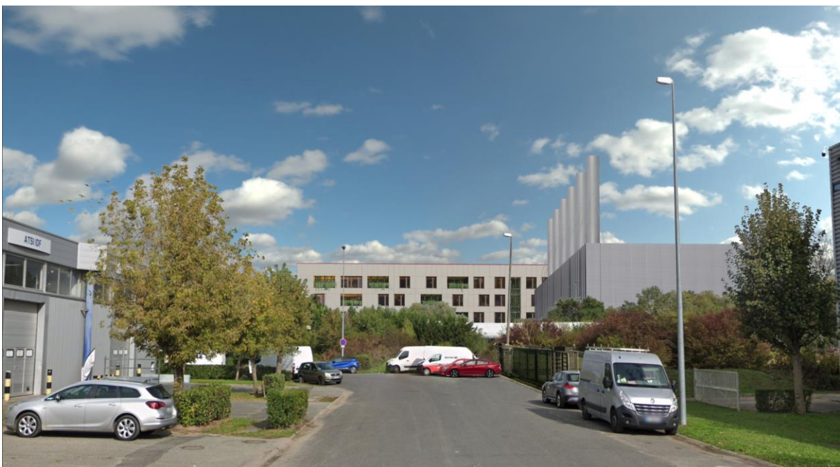
Vue du projet depuis l'accès secondaire depuis la rue Myosotis
