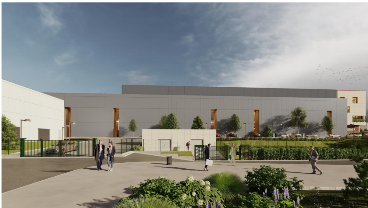
Vue de l'accès principal depuis la rue Myosotis
