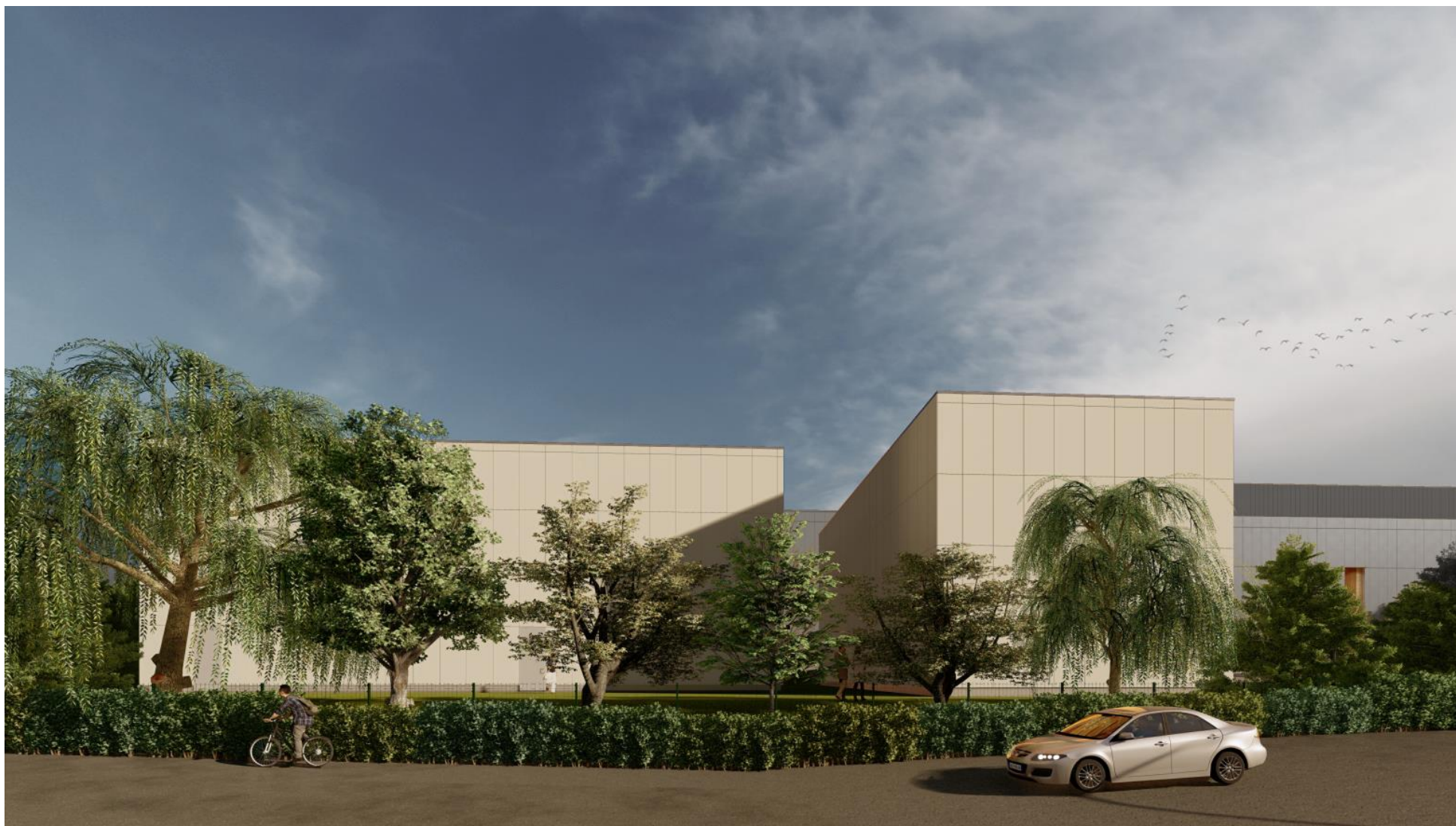
Illustration 9 : Perspective depuis l'avenue des Myosotis – Vue des bâtiments de transformateur et de poste électrique
