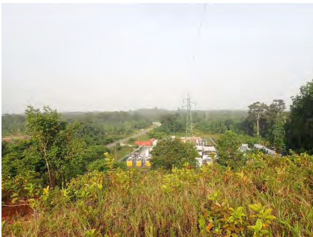
FIGURE 32 DESSOUS DE LIGNES ELECTRIQUES ET CENTRALE DE PRODUCTION ELECTRIQUE
