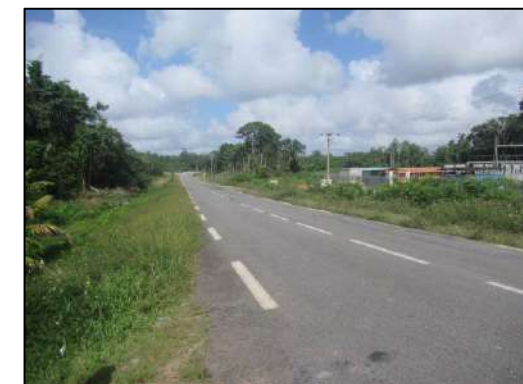
Figure 135 : Photo : centrale EDF et RN1
