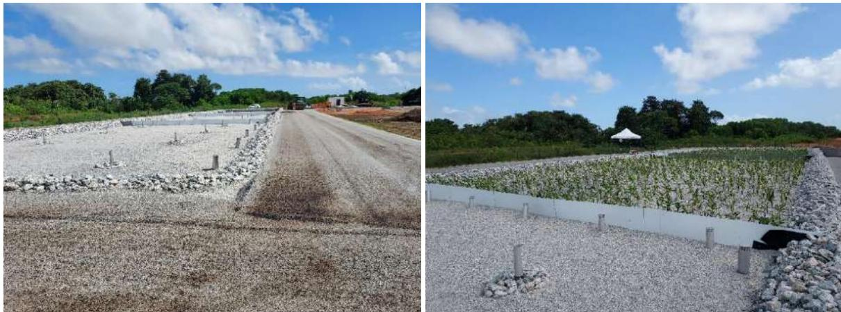
*Figure 25. Filtre planté de Maillard en cours de construction*
