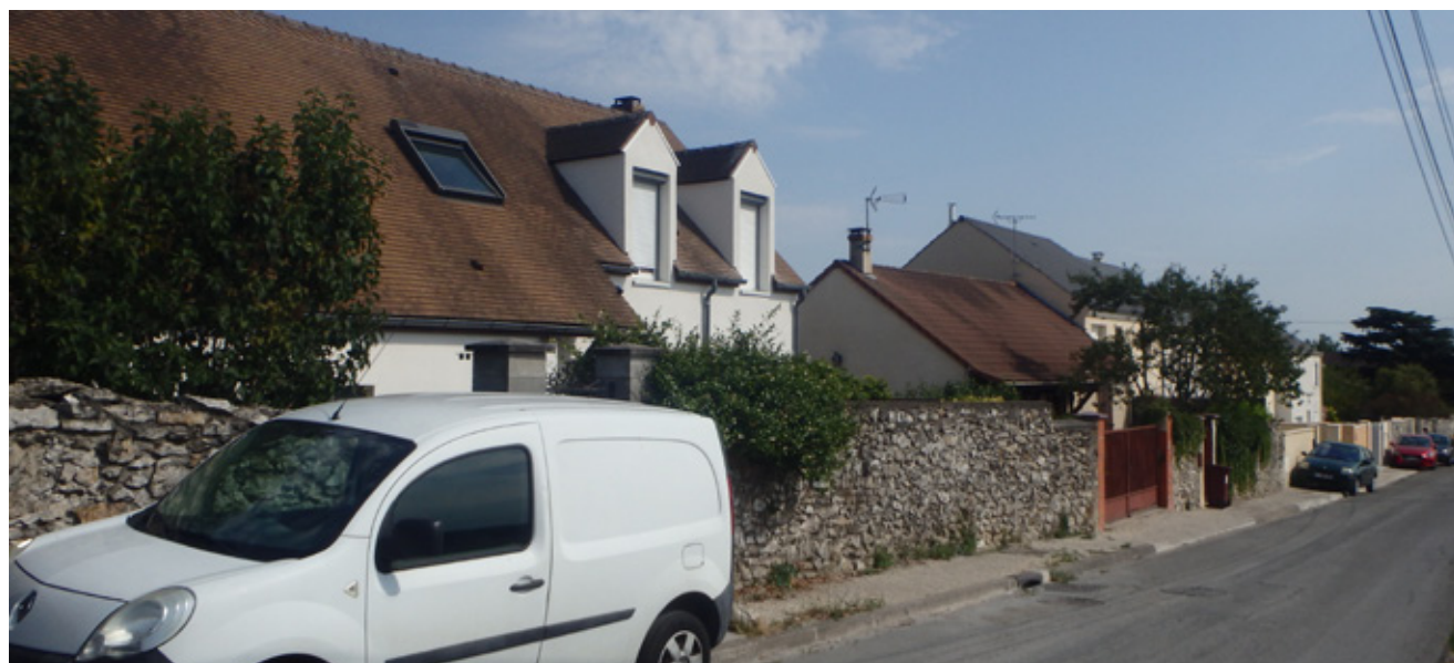
1- Depuis les habitations de Courtry en pied de coteau (2022).
