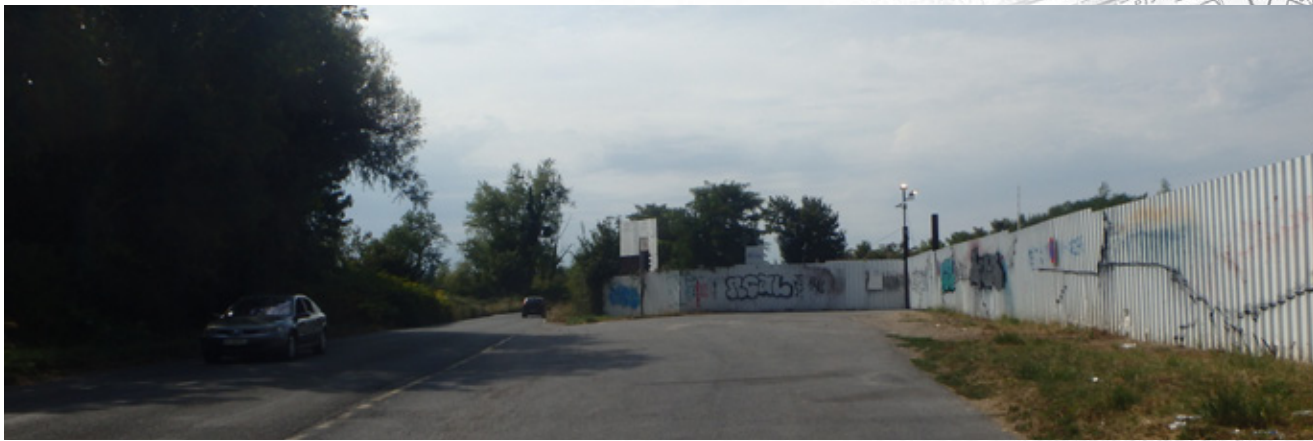
3- Seul l'accès à l'ancien CEA laisse deviner la zone en travaux (2022).
