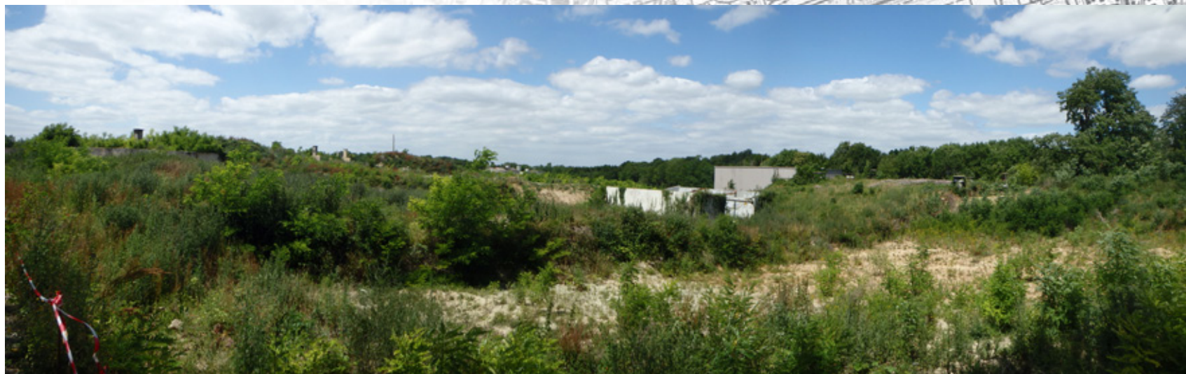
5- Les travaux de démolition du CEA ont été colonisés par la végétation spontanée (2017).
