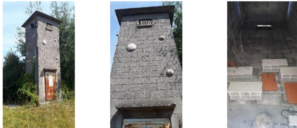
Figure 102. Installation de gîtes artificiels pour les chauves-souris sur un ancien poste électrique (site Placoplatre). A gauche et au centre, aménagement extérieur. A droite, aménagement intérieur avec des parpaings et briques (Ecosphère, 2018)
