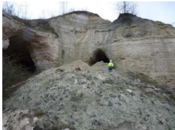
Figure 81. Cône d'éboulis à l'entrée du cavage Nord (Ecosphère, 2018)
