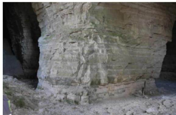
Figure 80. Dégradation de la base d'un pilier soumis aux altérations climatiques
