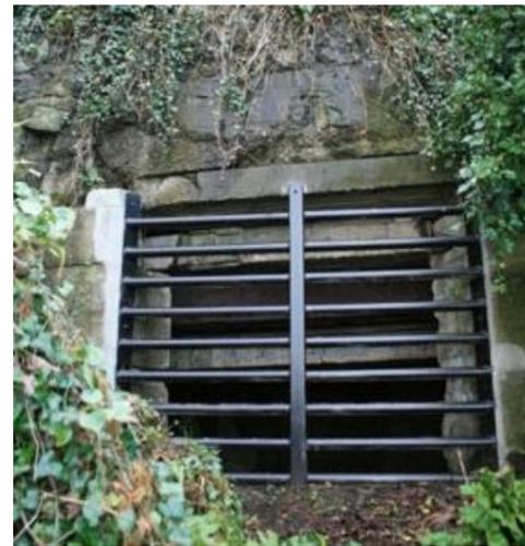
Figure 90. Types de grilles de protection utilisées à l'entrée d'une cavité de chiroptères
