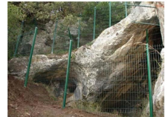
Figure 89. Types de grilles de protection utilisées à l'entrée d'une cavité de chiroptères (SFEPM, 2008)
