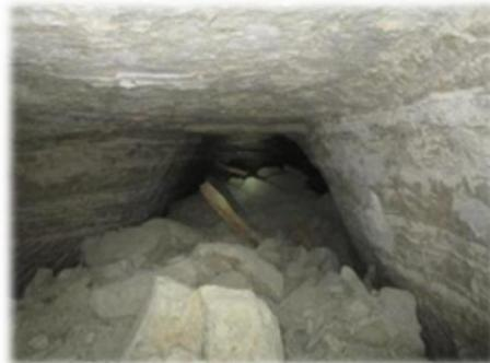
Figure 54. Cavage Est : vue de l'intérieur d'une galerie avec un remblaiement ancien en profondeur (Ecosphère, 2018)
