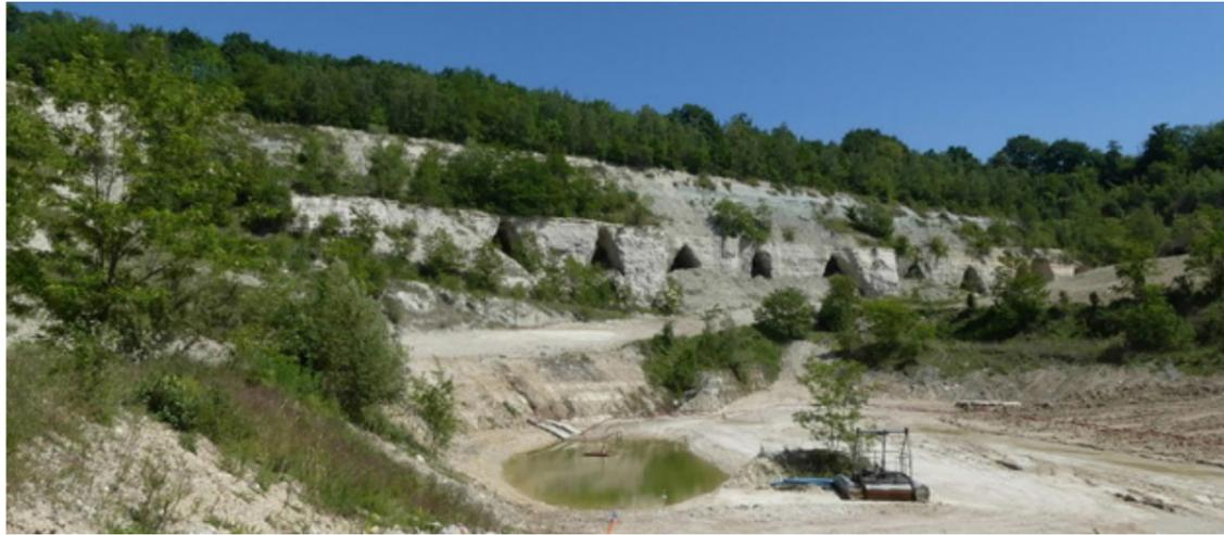
*Photo 4 : Vue des remblais positionnés aux entrées dans anciennes galeries souterraines*
